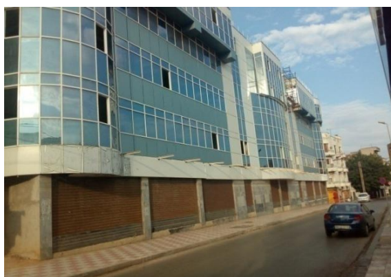
Figure II.46 immeuble de bureau et de commerce
