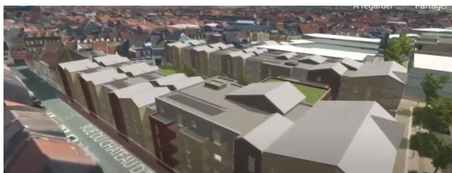
Figure II.53 Ville de calais rue de château d'eau.
