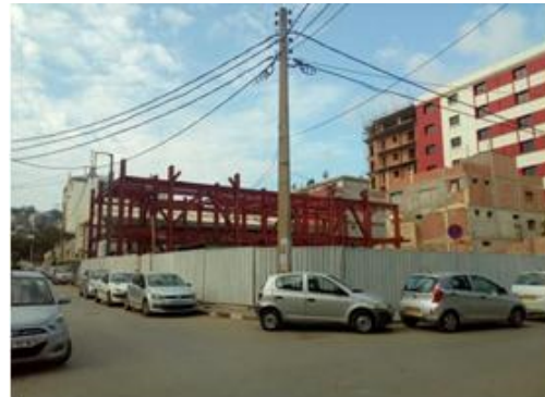
Figure II.50 Réalisation de la direction Naftal Rue Mekidi Amar
