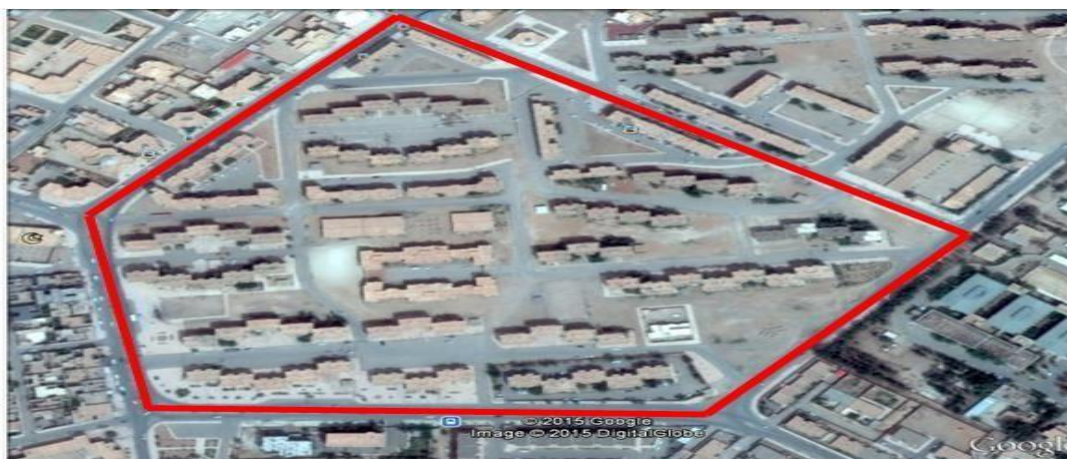
Figure III.41 La construction de cité 500 logements. Source : adapté de www.googleearth.com . Traité par l'auteur.
