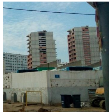
Figure II.51 Tours de bureaux Rue des frères Moukhtari
