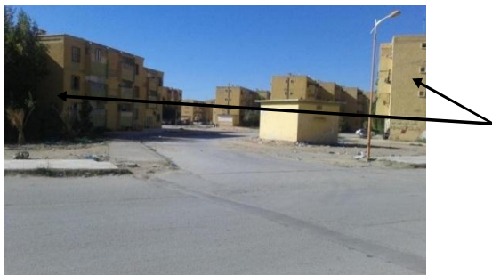
Figure III.39 Les façades aveugles des blocs de cité. Source : l'auteur 28/03/2022.
