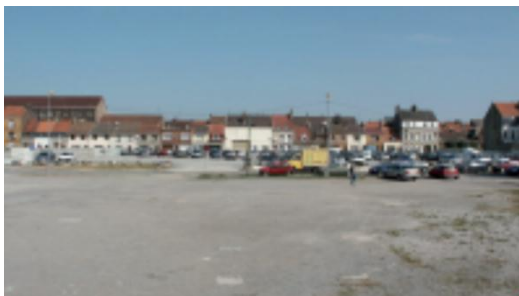
Figure II.56 Aménagement d'une nouvelle voirie de desserte et d'une aire de jeux-état existant
