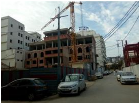
Figure II.49 Réalisation de l'extension APC Rue Mekidi Amar
