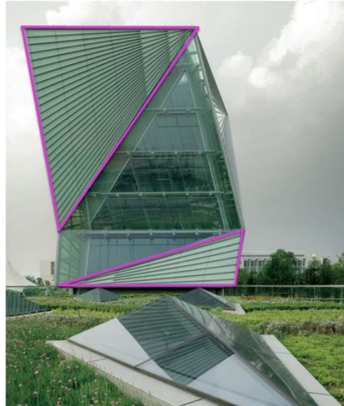
Fig I .22 : façade du projet
