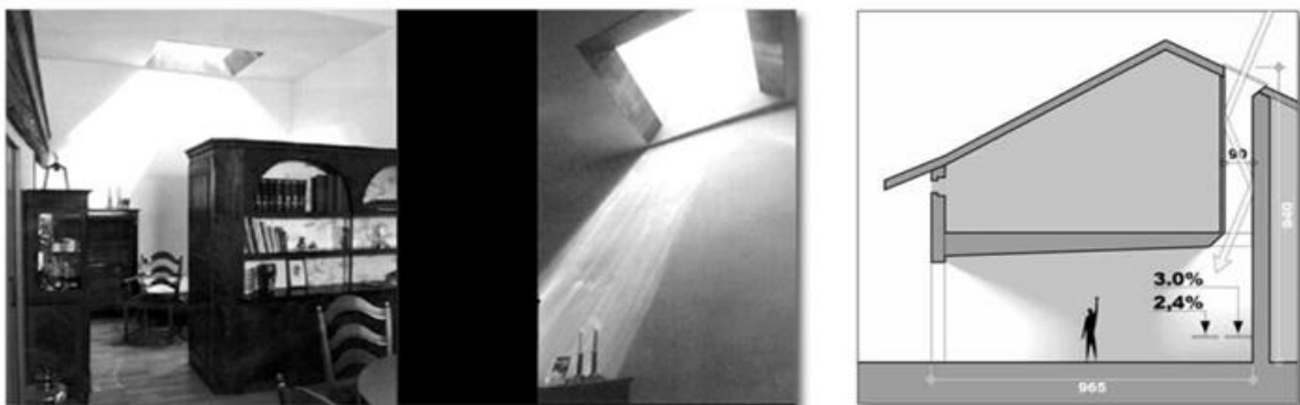
Fig VI.22 : Utilisations des cheminées de lumière (Source : www.energieplus-lesite.be )
