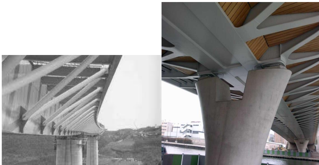
Figure I.12. Ponts mixtes en caisson.
