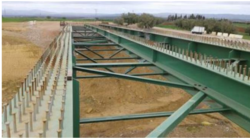
Figure II.5.La connexion par goudjons.
