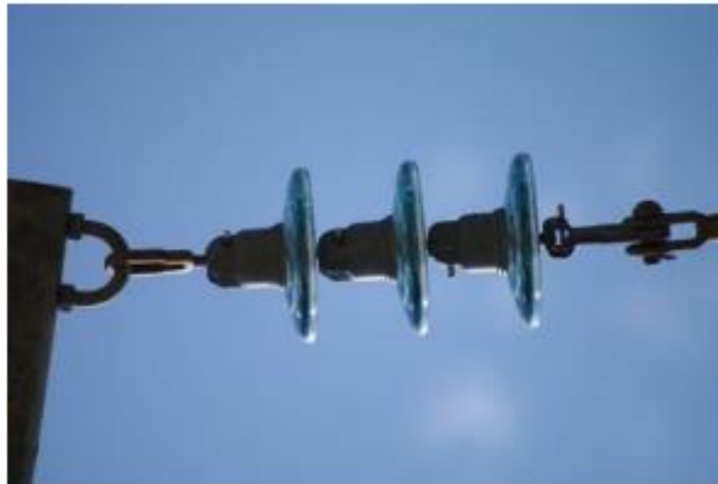
Figure I-3: Chaîne de trois isolatrices hautes tensions
