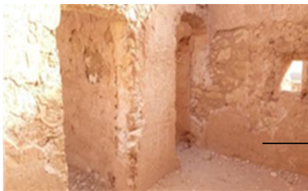
Détachement de crépissage
