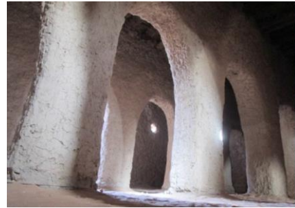
Figure 32: intérieur de la mosquée source : auteures
