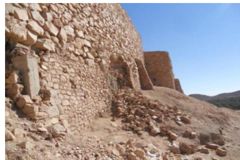
Figure 41: le 2 ème rempart source : auteurs
