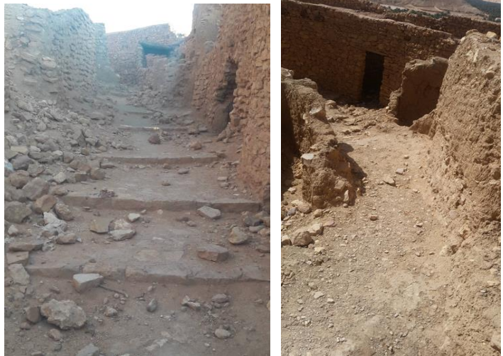
Figure 34: l'état des rues source : auteure
