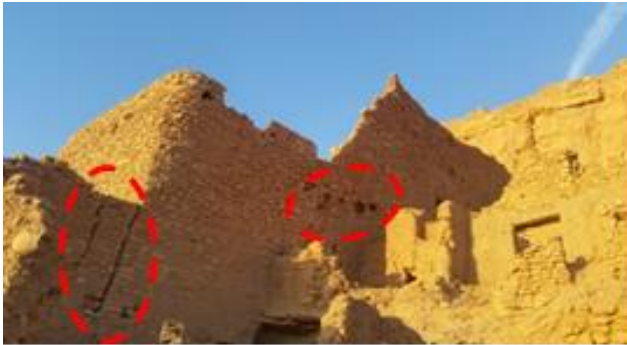
Figure 11: fissuration profonde source : auteure
