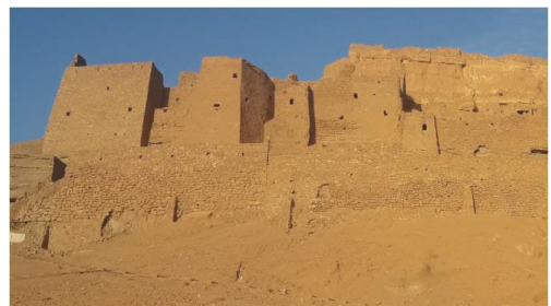
Figure 50: la façade de la tour de la kasbah source : auteures
