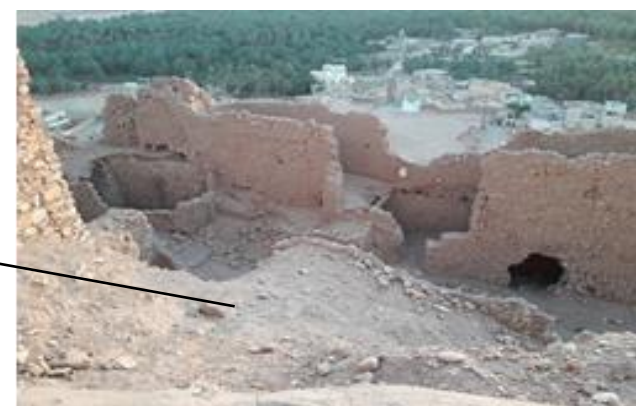
Effondrements total di maison rempart
