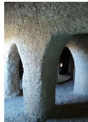
Figure 57: les colonnes de la mosquée source : auteures
