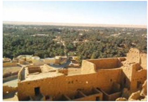
Figure 6: effondrement du plancher de la tour source : auteure
