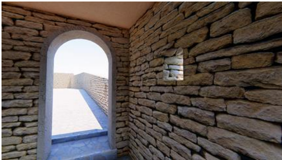
Figure 26: vue sur la porte source : auteure.
