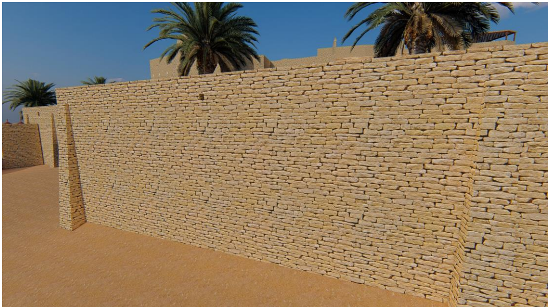
Figure 23 : vue sur le rempart du ksar El-Goléa source : auteure
