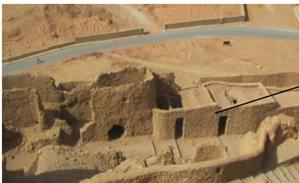
Effondrement du plancher
