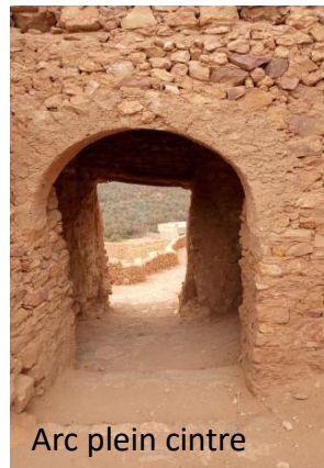
Figure 59: les éléments architectoniques dans le ksar source : auteures
