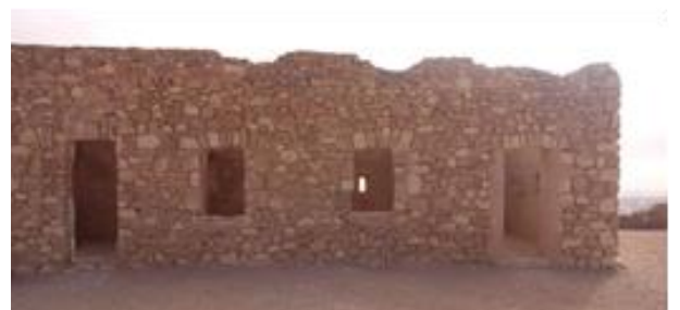
Figure 14: la perte des fenêtres et les porte de tour française source : auteure
