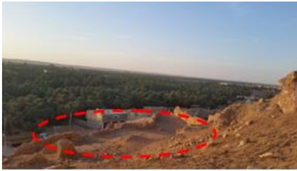
Figure 7: effondrement de mur rempart source : auteure
