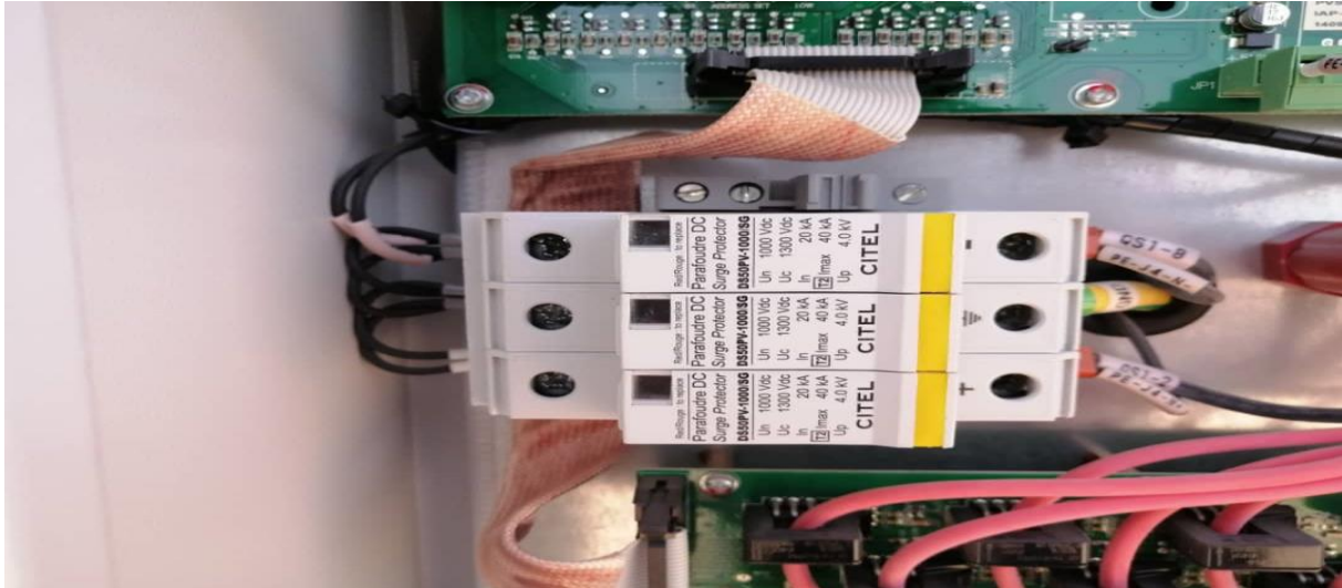
Figure III.11: protection contre les surtensions (parafoudre)
