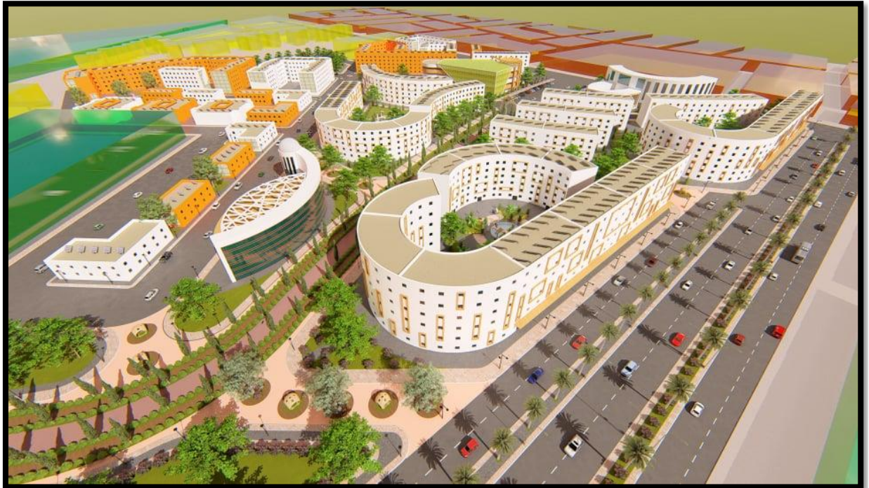
Fig. 100 : les panneaux photovoltaïques. Source : établie par les étudiantes
