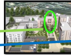
Fig. 38 : La déconstruction des logements. Source : https://www.youtube.com/watch?v=eytxBiHwgZA
