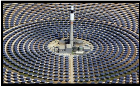
Fig. 52 : Centrale solaire thermique expérimentale Source : https://webdeveloppementdurable.com/dossier-masdar-loasis-verte-au-pays-de-lor-noir/3/
