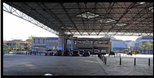
Fig. 09 : suppression de toiture. Source : Torcy, val-Maubuée, marue-la-ballée.pdf/p :04
