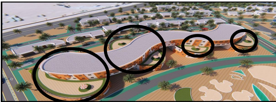
Photo 47 jardin terrasse Source : par l'auteure
