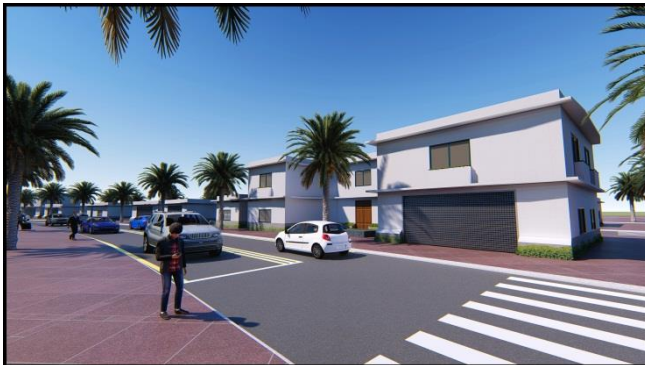
Photo 44 habitat individuelle Source : par l'auteur
