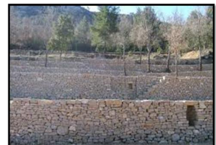
Photo 66 : pierres hourdées au mortier
