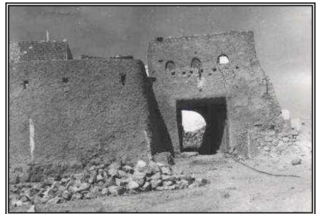
Figure 29 porte ancien "Bab Bentrache" Source : O.P.V.M.(2006)
