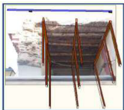
Figure II.49 : consolidation du plancher avec étaielements en bois au niveau de l'espace d'ablution Source : PPMVSA
