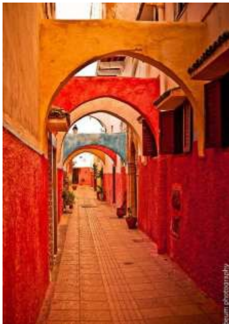
Photo II.43 : ravalement et embellissement des façades Source : https://www.pinterest.fr/pin/575616396100686929/
