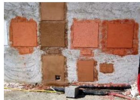
Photo I.18 : enduit de terre et de chaux
