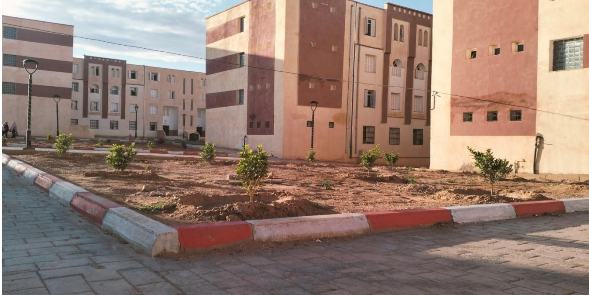
Figure 12 : photo dela résidence universitaire Bouchareb Taher originale 2023.
