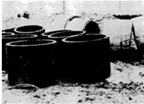
Figures I-4 Eléments annulaires de collecteurs pour canalisations souterraines urbaines
