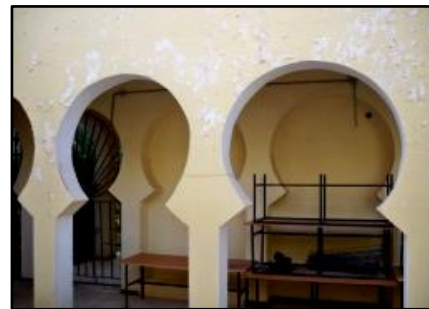
Figure I- 68: vue sur les arcades Source : archives centre BenKeriou
