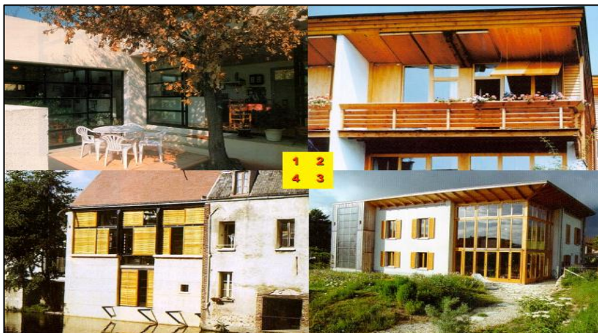
Figure V- 14: exemples de quatre types de protections solaires Source : A. Liébard, A. de Herde 2005.
