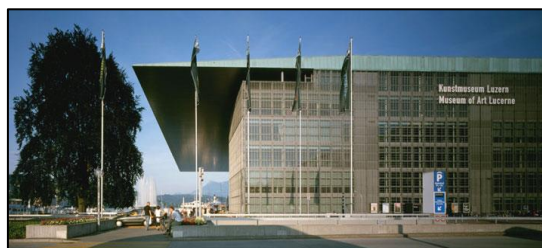
Figure I- 35: l'énorme toit Source : www.kunstmuseumluzern.ch
