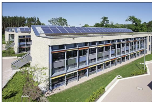
Figure I- 17: l'école primaire de Hohen Neuendorf Source : www.batirama.com
