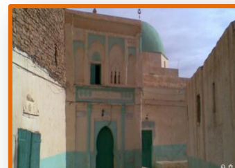
Figure 54: mosquée du vieux k'sar Source : photo prise par les étudiantes
