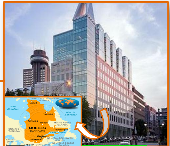
Figure 16: Siège social de La Capitale Source : (ecochantier.lacapitale.com)
