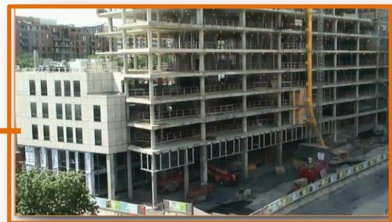
Figure 26 : le chantier de siège social de la capitale Source : (ecochantier.lacapitale.com)
