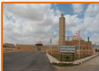
Figure 53: la mosquée de la zaouia Tidjania Source : photo prise par les étudiantes
