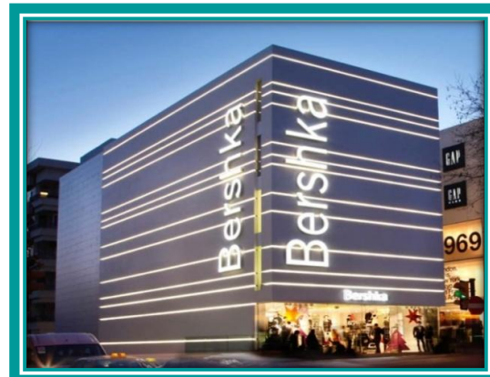
Figure 7-15 Magasin Bershka à Istanbul, Turquie. Architectes : CastelvejanaArquitectura Source : www.krion.com
