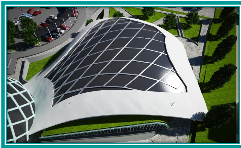
Figure 7-46 le vitrage photovoltaïque du coque / source: auteur
