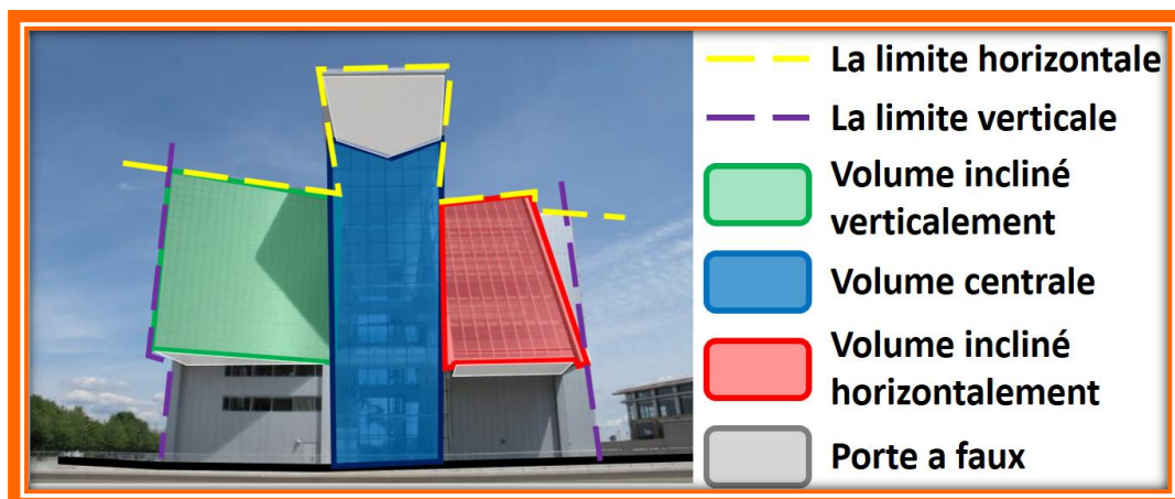
Figure 3-8 La façade principale de Connecticut Science Center / Source : Auteur
