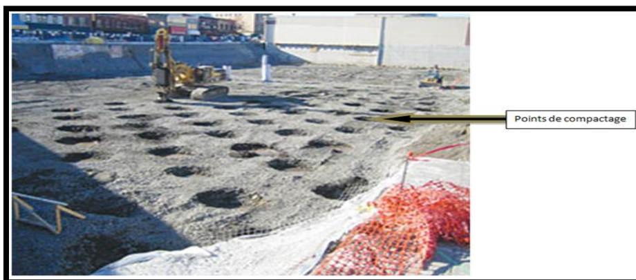
Figure 43 : chantier en compactage
