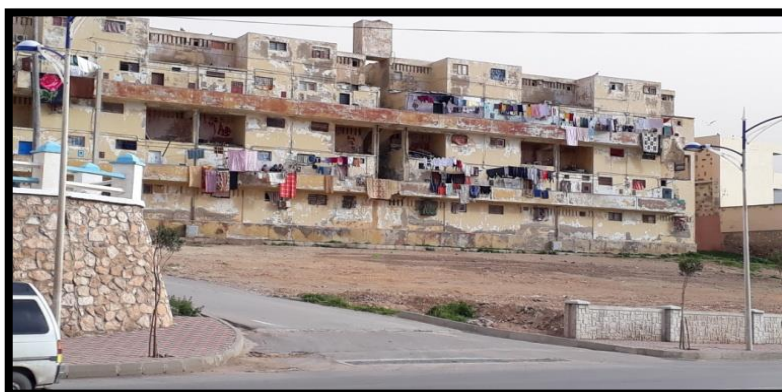
Figure 112 : l'état du bâti dans la zone d'intervention source : pris par l'auteur le 28/02/2018 à 17 :13
