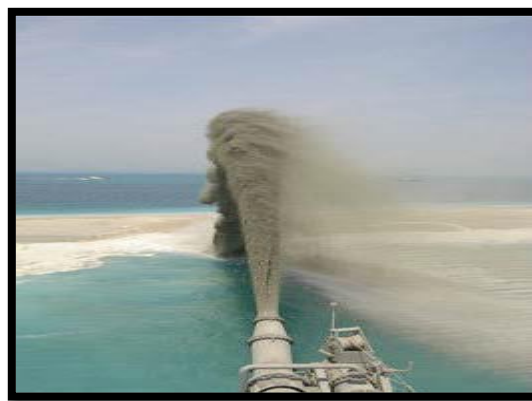
Figure 50 : présente le Jet de sable pour constituer les îles source : http://tpedubai.e-monsite.com/pages/construction-et-point-de-vue-economique.html 21/05/2018 à 03 : 07
