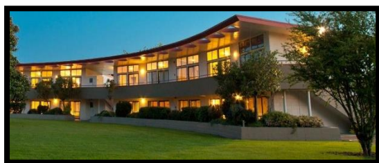
Figure 28 : motels en Nouvelle-Zélande Source : www.newzealand.com 18/05/2018
