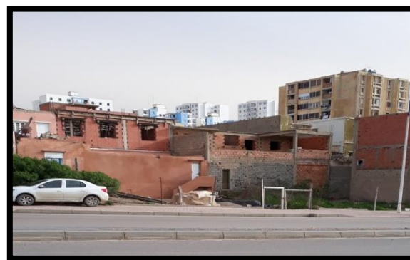
Figure 111 : l'état du bâti dans la zone d'intervention source : pris par l'auteur le 28/02/2018 à 17 :13
