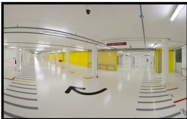
Figure 147 : parking sous-sol source : www.cenoviapark.fr le 22/06/2018 à 16 :24
