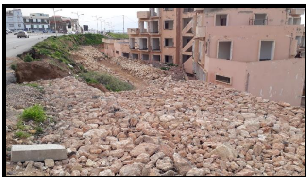
Figure 110 : l'état du bâti dans la zone d'intervention source : pris par l'auteur le 28/02/2018 à 17 :10
