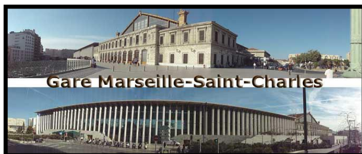
Figure 55 : présente saint Charles source : https://www.provence7.com/portails/vie-pratique/gare-saint-charles-de-marseille/ 03/06/2018 à 23 :36
