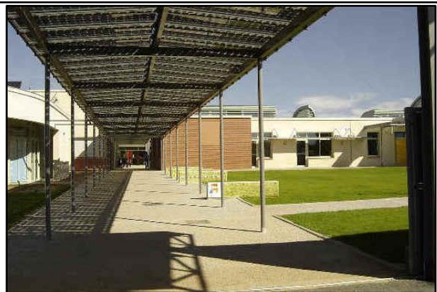
Figure 09 : Parcours couvert (Source :outilssolaires.com )
