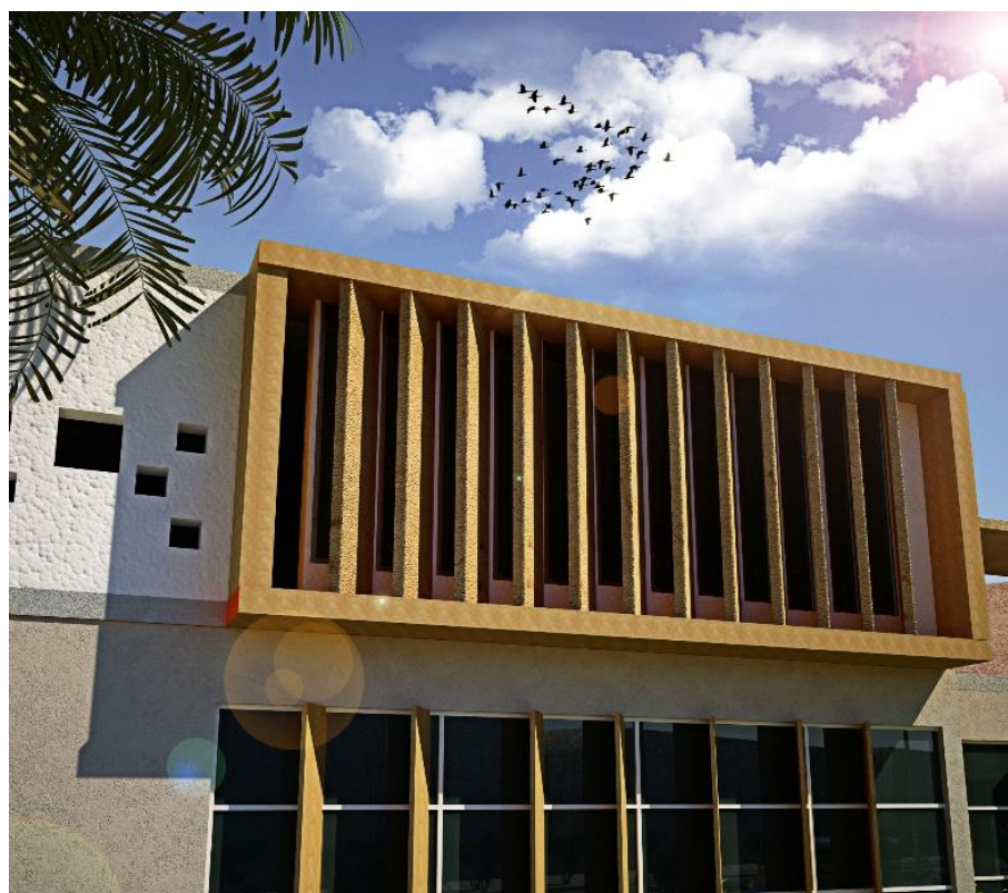
Figure 78 : Les brises soleil verticaux (Source : Auteurs).
