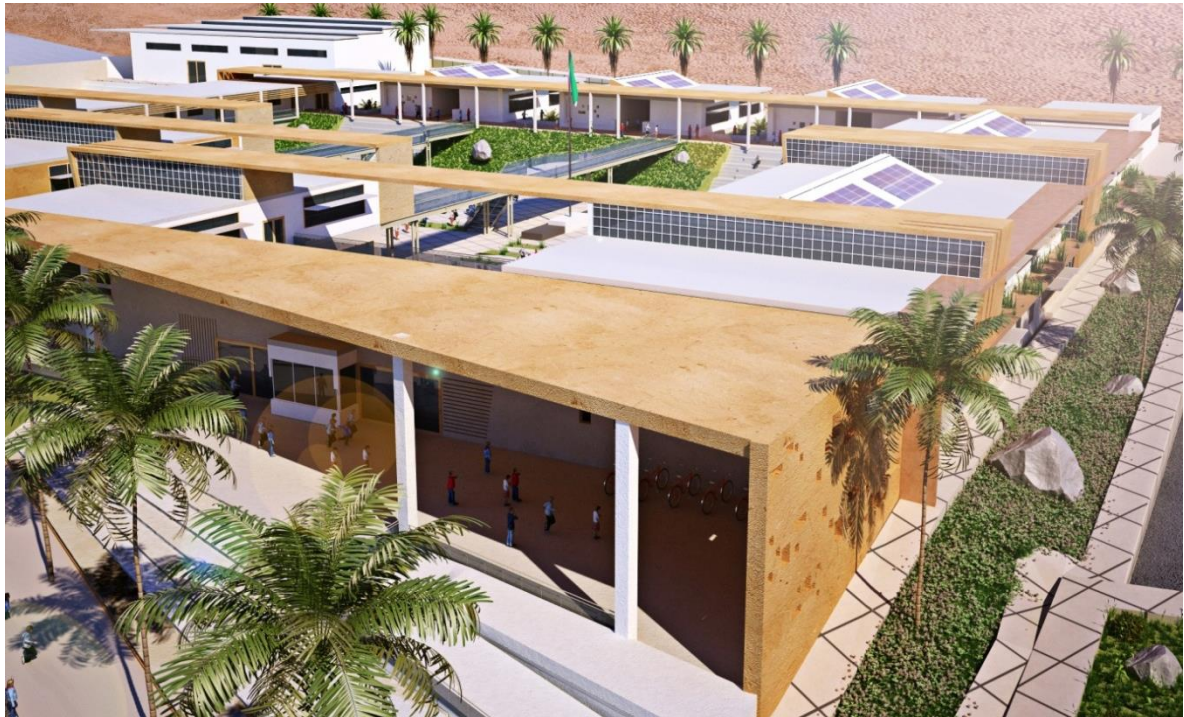
Figure 81 : Vue générale sur le projet (Source : Auteurs).
