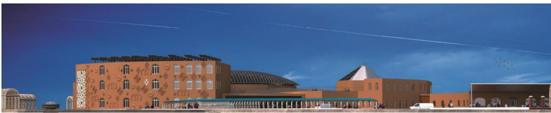
Figure N18 : Façade principale, Source : Auteur
