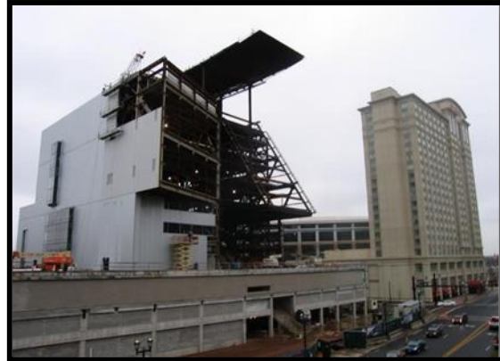
Fig. 61 Photo de la structure métallique
