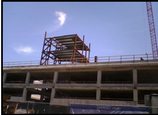
Fig.60 Photo de la structure en béton armé
