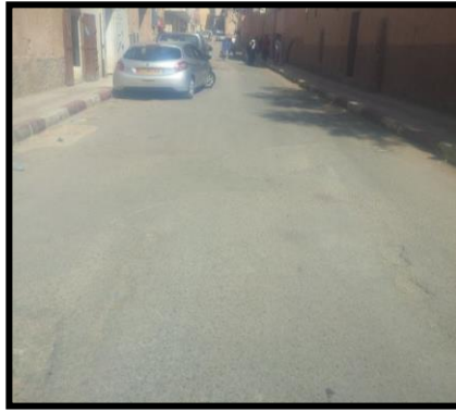
Fig. 120 : vue de la voie tertiaire
