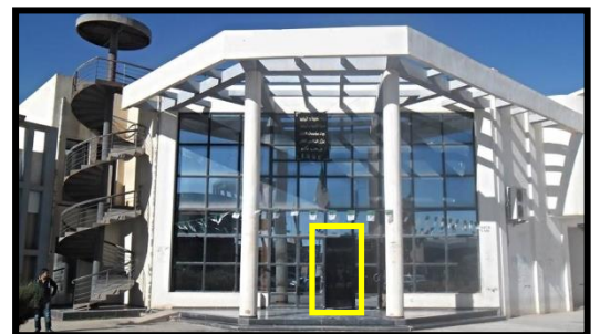
Fig70 : Entrée principale du projet Source : auteur
