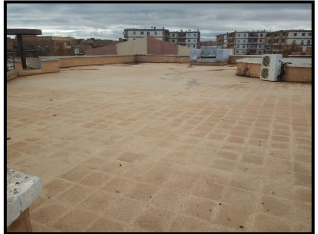
Fig. 90 : Photo montre la terrasse Source : auteur
