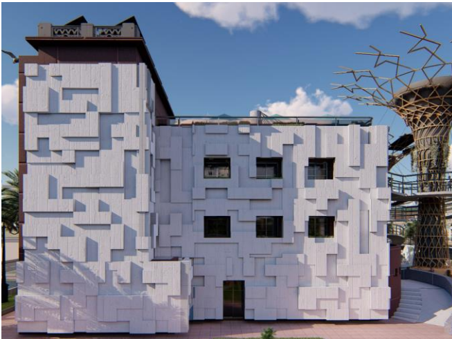
134 : Vue façade Est
