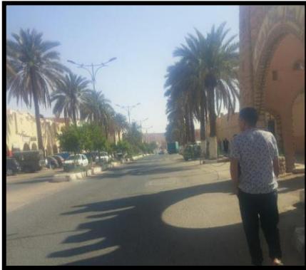
Fig. 119 : vue de la voie principale
