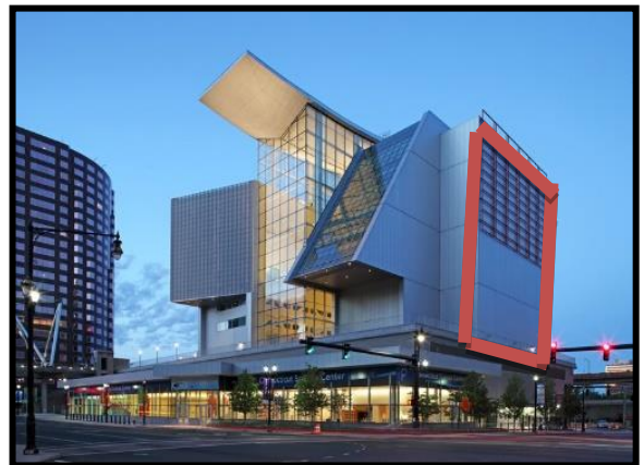
Fig. 44 : Photo de la Façade Sud
