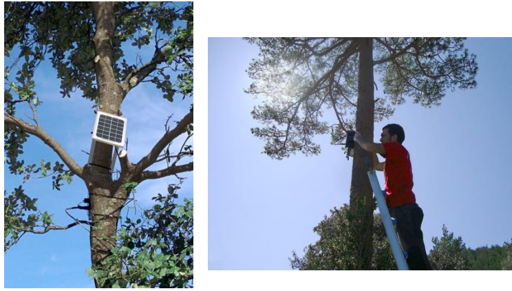
Figure 1.8 : Installation des capteurs Libelium en forêt pour détection des incendies
