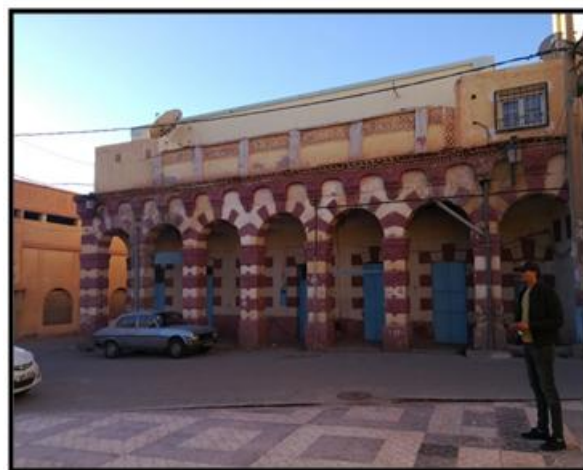
Figure 109: L'ancienne façade commerciale / source : photo prise par l'auteur.
