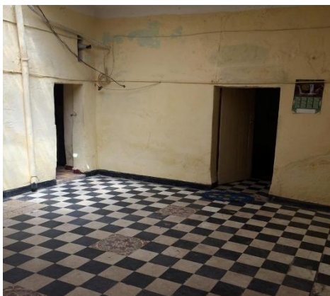
Figure 44 : cour couverte récemment Source : prise par l'auteur
