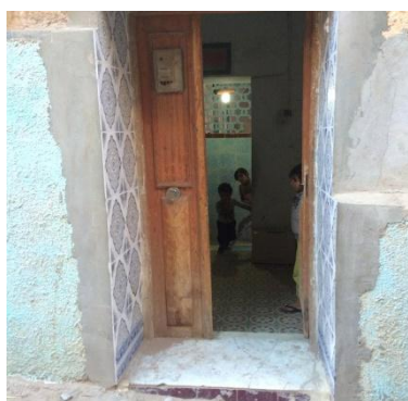
Figure 34 : porte de la maison Source : prise par l'auteur
