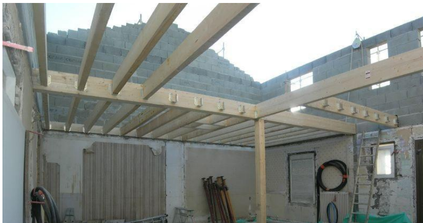
Figure 15 : Placement des poutres en bois de sciage
