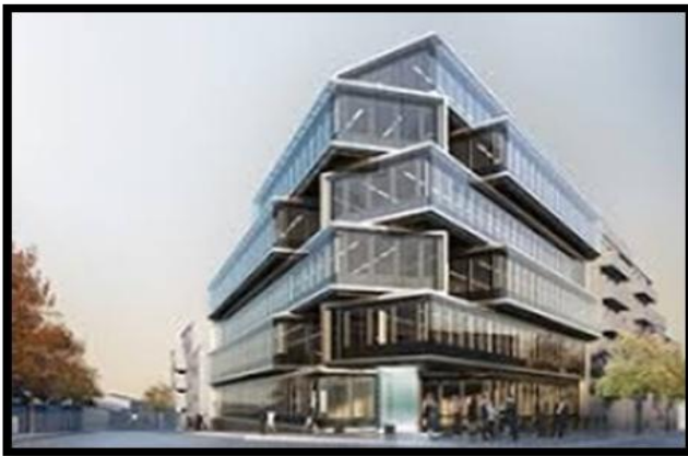
Figure 8 : construction en Acier
