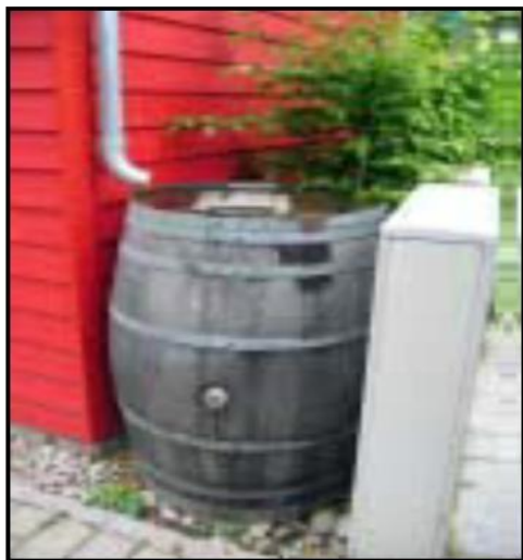
Figure 12 : Citerne de récupération des eaux de pluie
