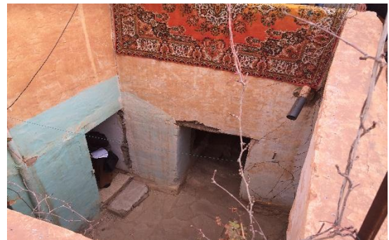
Figure 46 : vue sur cour Source : prise par l'auteur
