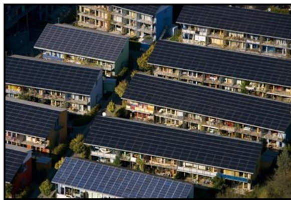
Figure 11 : les panneaux photovoltaïques
