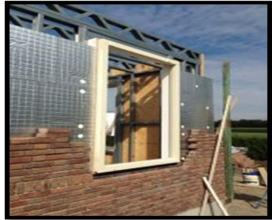
Figure 9 : construction en Acier
