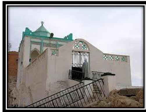
Figure 105: Quobat Sidi Abdelkader / source : prise par l'auteur
