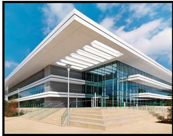
Figure 10 : la construction en aluminium
