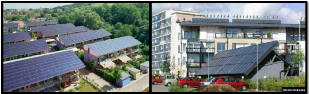
Figure 24 : les panneaux solaires et photovoltaïque utiliser dans les bâtiments du quartier,
