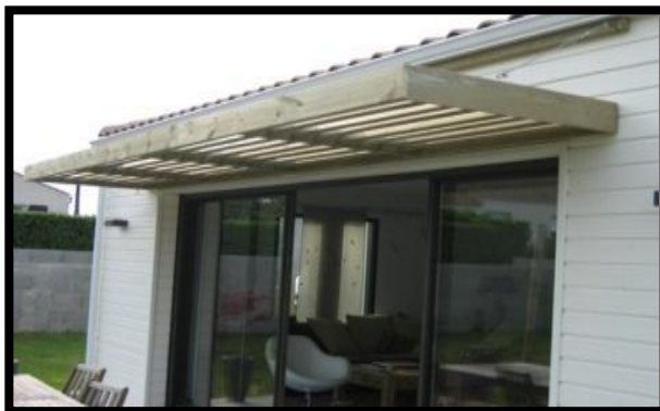
Figure 29 : brises solaires intégrer dans un habitat
