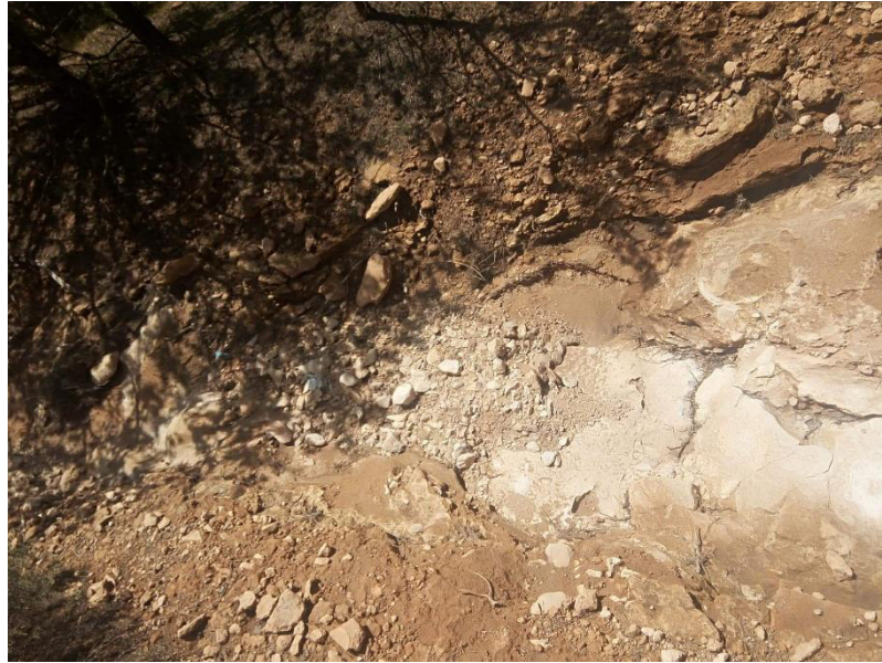
Photo 04 érosion Hydrique originale 2018
