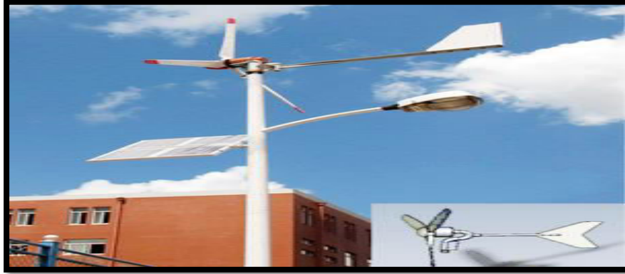
Figure III.1 : Eclairage public utilisant source hybride solaire-éolienne [17]
