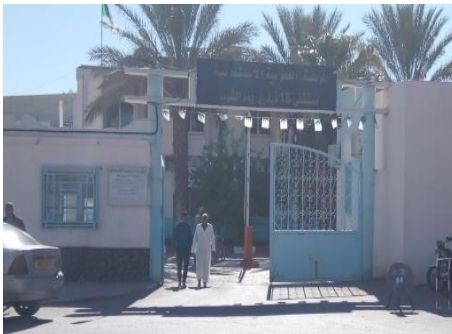
صورة 79 : مستشفى 18 فيفري المصدر : تصوير ميداني
