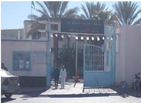
صورة 79 : مستشفى 18 فيفري المصدر : تصوير ميداني
