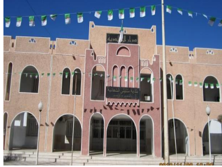
صورة 75 : مقر البلدية المصدر : تصوير ميداني
