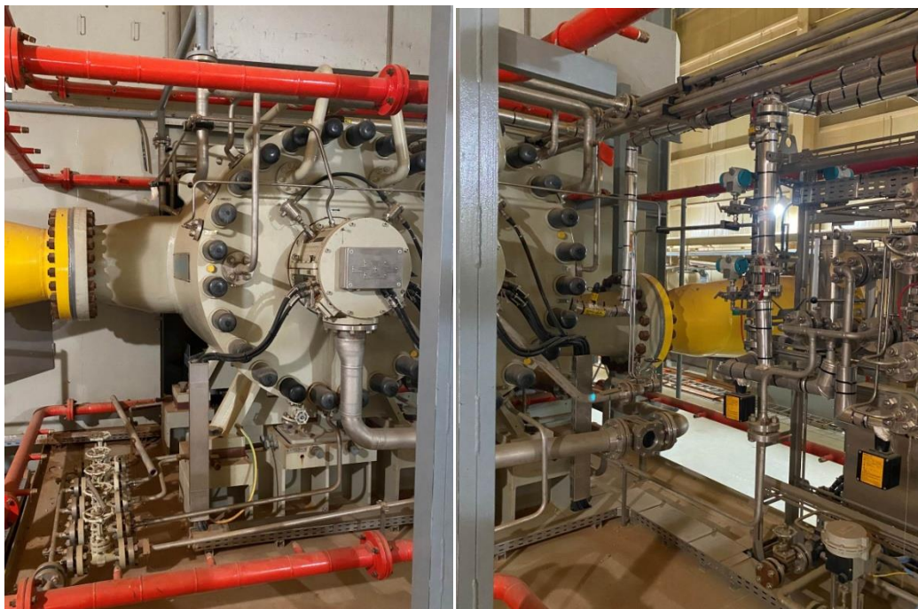
Figure 2. Compresseur de la turbine.
