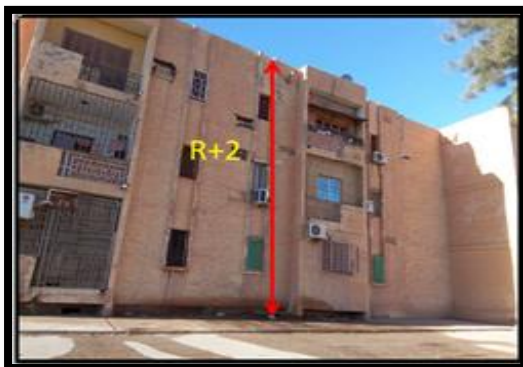
Photo N°22: Les habitats collectifs dans le quartier 482 logements. /Source :les étudiantes.
