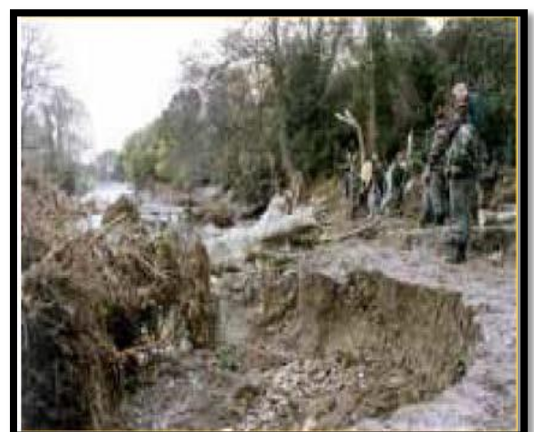
Figure N°09 : glissement de terrain. Source : [cour urbanisation et risque majeur]
