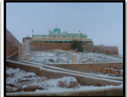
Photo N° 12 : Marabout sidi Hadj Aissa. /Source : http://le-phenix.emonsite.com .
