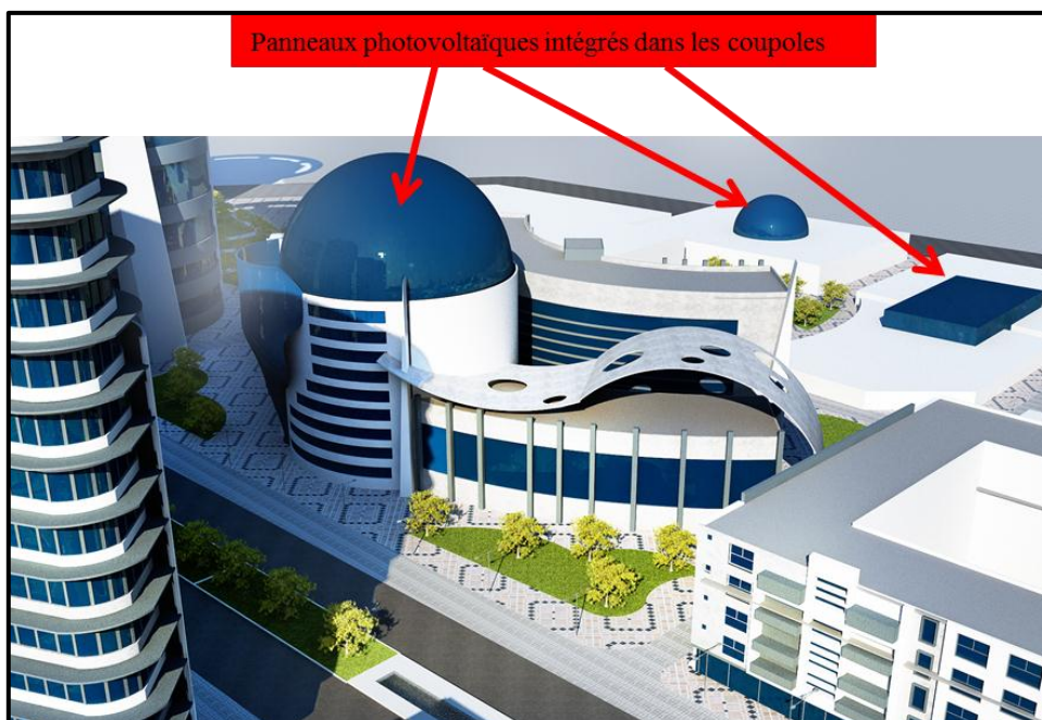
Figure IV-17 : panneaux photovoltaïques intégrés dans les coupoles
