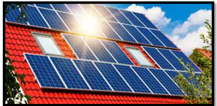
Figure IV-05: les panneaux photovoltaïques
