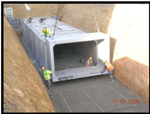
FigureI-11 : les bassins de stockage Source : www.hellopro.fr
