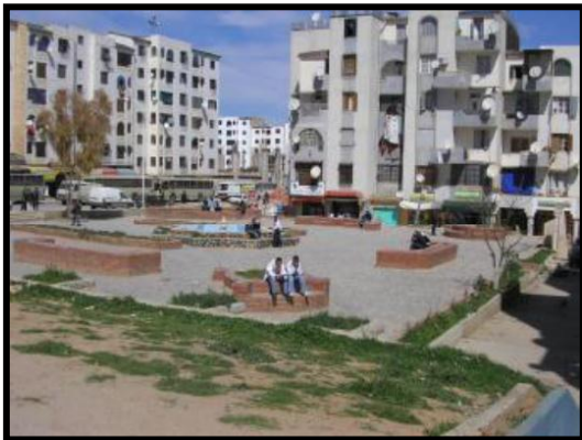
FigureII-06 : les espaces publics dégradés Source : lecourrier-dalgerie.com
