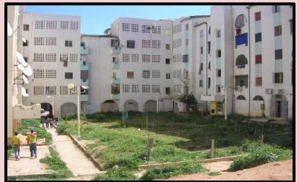
FigureII-09 : les espaces publics dégradés Source : lecourrier-dalgerie.com
