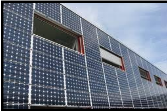
Figure IV-09 : photovoltaïques en façades Source : www.solaire-photovoltaïque-pro.fr
