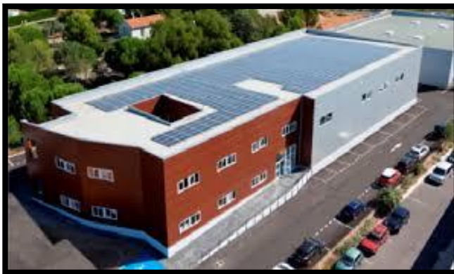
Figure IV-11: les photovoltaïques en toiture terrasse Source : dualsun.fr
