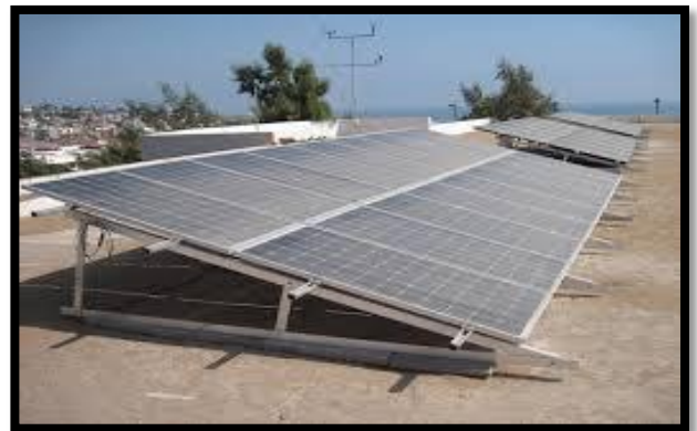
Figure IV-12 : les photovoltaïques en toiture terrasse Source : ma.krannich-solar.com
