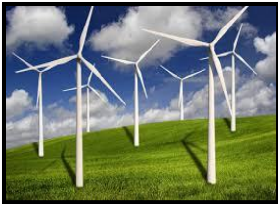
Figure IV-01 : les éoliennes Source : tpe-2012-les-eoliennes.e-monsite.com
