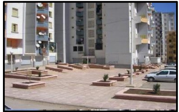
FigureII-07 : les espaces publics dégradés Source : lecourrier-dalgerie.com
