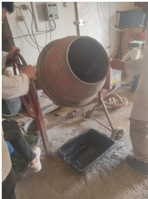
Figure 2.11 : phase de bétonnage
