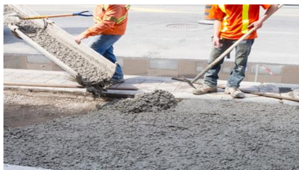
Figure 1.7 : Coulage d'une chaussée rigide. [6]
