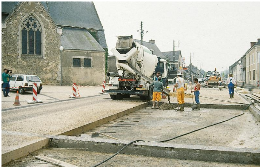
Figure 1.1 : La mise en œuvre du béton de chaussée [1]
