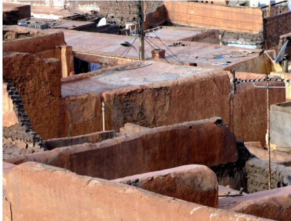
Figure 30 : Antennes et mats électriques fleurissant sur les terrasses.
