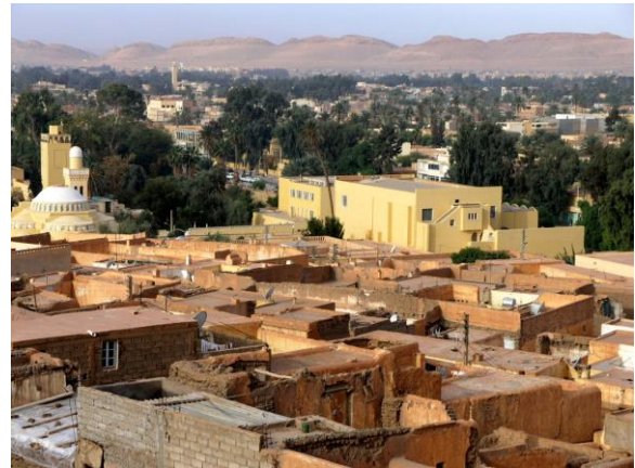
Figure 31 : nouvelles constructions paradoxales.
