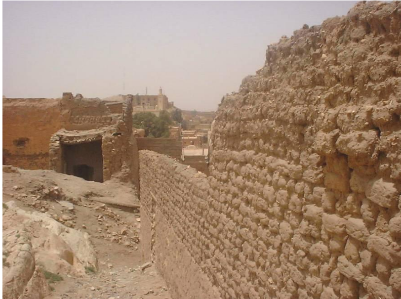
Figure 21 : murs en briques d'adobe.
