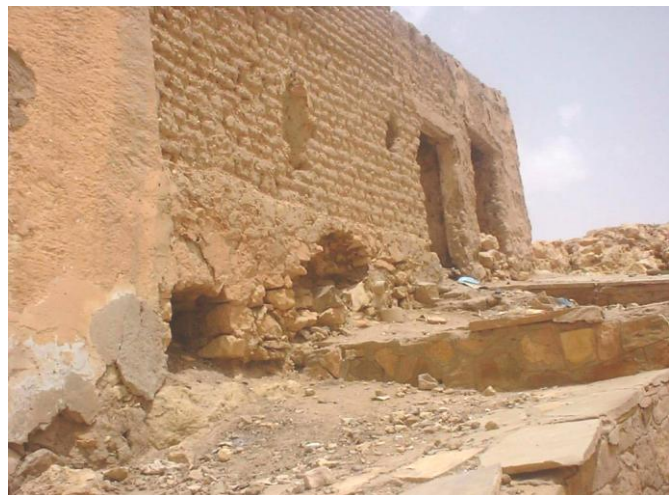
Figure 23 : Assises des murs en pierres sèches Source : Etudiants Département architecture 3 ème année (2005-2006)
