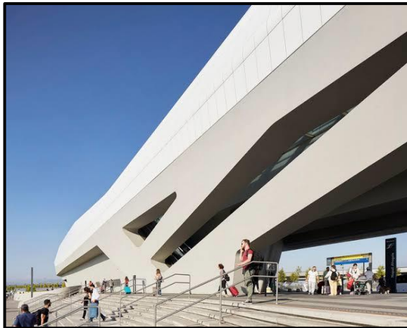
Figure I 22: Photo de l'une de l'entrée de la gare Napoli.
