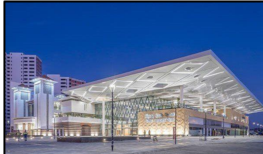
Figure I 11: l'entrée principale de nouvelle Gare Tanger –Maroc
