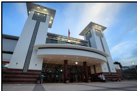
Figure I 10: l'entrée principale de l'ancienne Gare Tanger –Maroc
