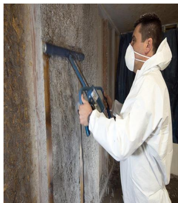
Figure V. 4: L'application de la Ouate de cellulose
