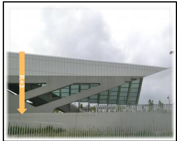
Figure I 21: Photo des façades de la gare Napoli.
