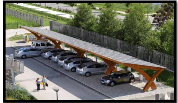
Figure 1.31 : photo de parking solaire
