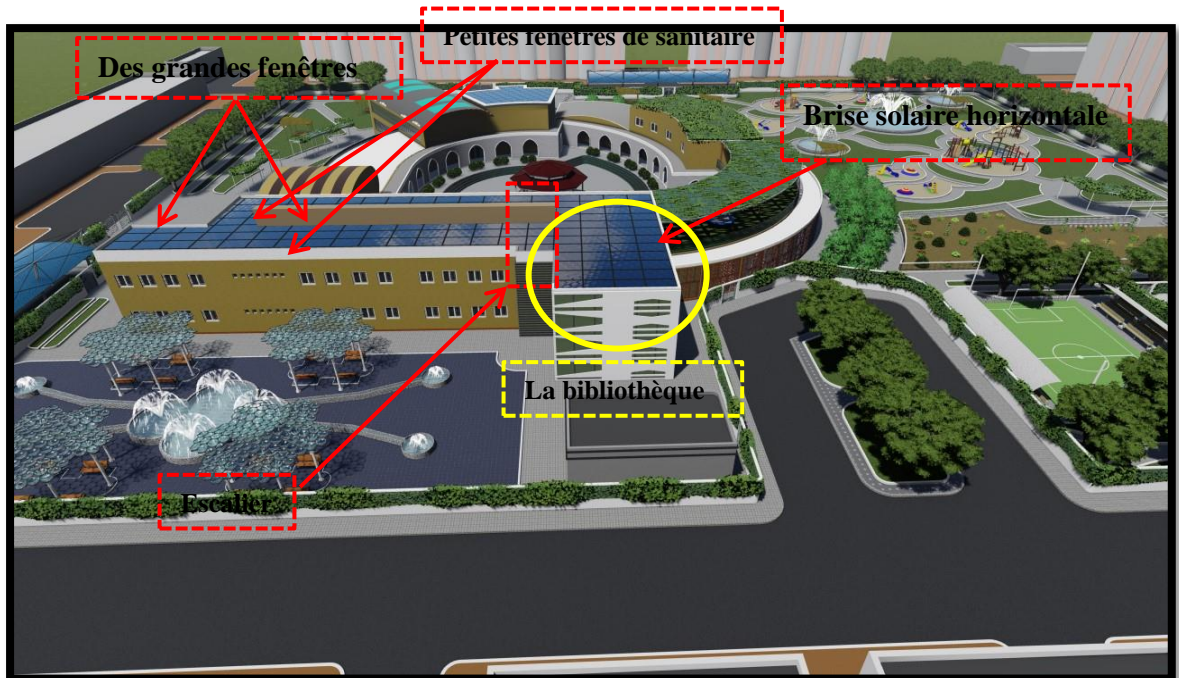
Figure 1.14 : façade nord/est (bloc pédagogique).
