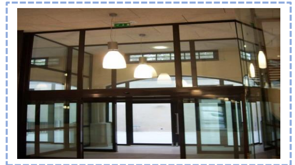
Figure 1.61: Vue de le sas, Source : http://www.fabalutec.fr
