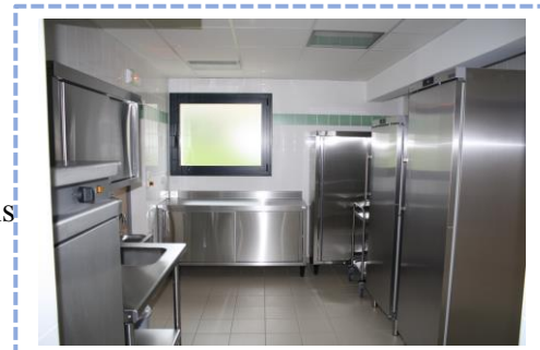
Figure 1.66 : Vue de la cuisine, Source : google image
