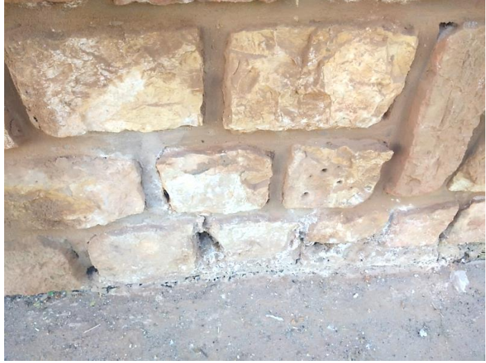
الشكل رقم: II. 33: يوضح نوع الحجارة المستعملة في أساس المدرسة (المبنى الداخلي) المصدر: من اعداد الطالبة
