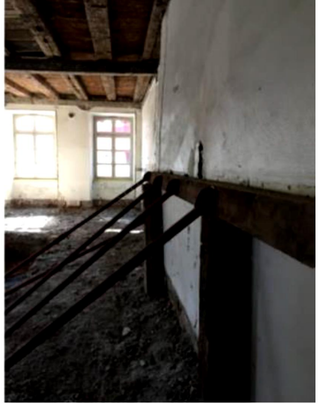
الشكل رقم: I. 19 : تدعيم الجدران أثناء عملية إعادة التأهيل المصدر:
