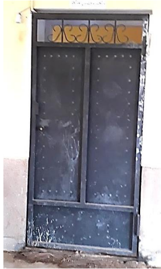
الشكل رقم : III. 31: يوضح استعمال أبواب حديدية المصدر: من اعداد الطالبة
