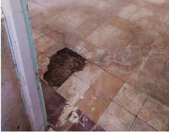
الشكل رقم : III. 22: يوضح تآكل البلاط والدرج
