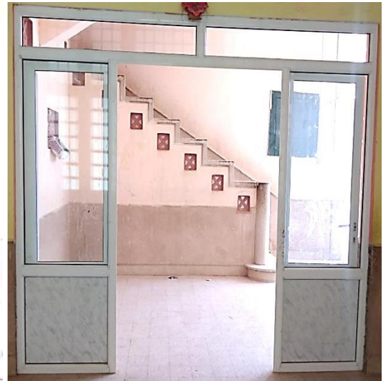
الشكل رقم : III. 31: يوضح استعمال مادة الالمنيوم في مدخل المدرسة المصدر: من اعداد الطالبة
