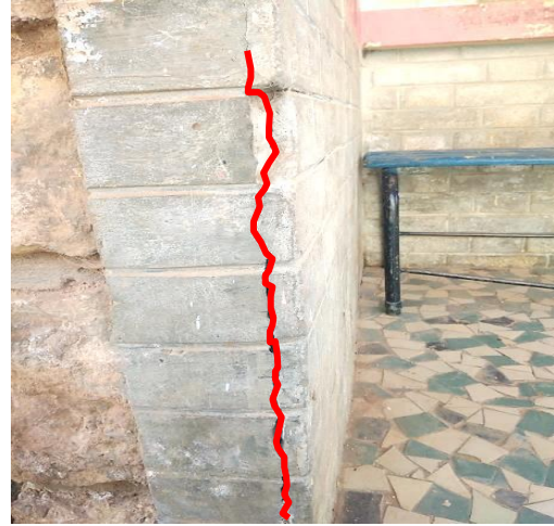
الشكل رقم : III. 19: يوضح التشققات العميقة في المدرسة
