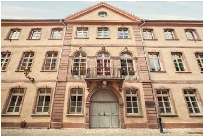
الشكل رقم: I. 20 : الواجهة الرئيسية للمبنى المصدر:
