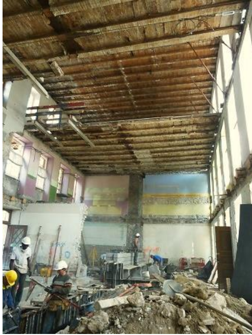
الشكل رقم: I. 25: الطوابق الوسطى للمبنى المصدر:
