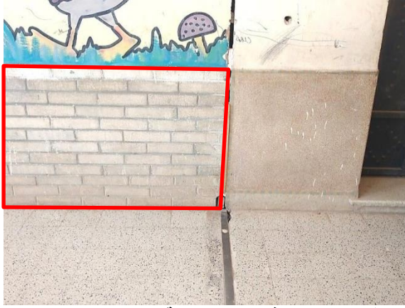
الشكل رقم: II. 35: يوضح الآجر المستعمل في بماء المدرسة
