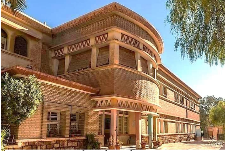
الشكل رقم: II. 16 : يوضح الواجهة الرئيسية لمدرسة محبوبي الحاج
