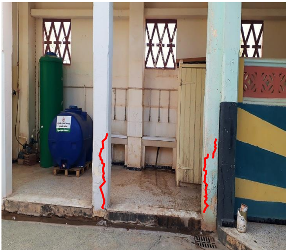
الشكل رقم : III. 20: يوضح التشققات البسيطة في المدرسة
