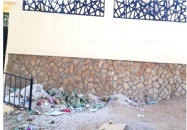
الشكل رقم: II. 34: يوضح نوع الحجارة المستعملة في أساس المدرسة (السور الخارجي) المصدر: من اعداد الطالبة
