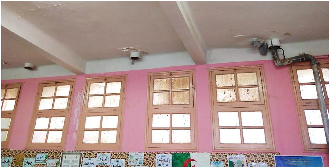
الشكل رقم: II. 25: يوضح آثار قنوات صرف الغاز
