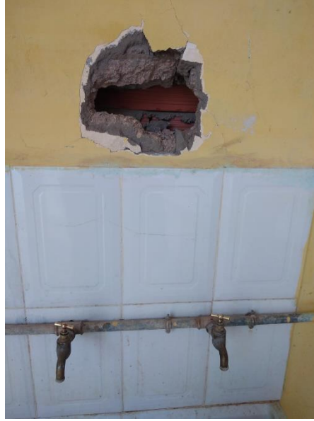
الشكل رقم : III. 21: تآكل الملاط وقوط التلييس المصدر: من اعداد الطالبة
