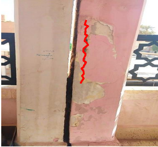
الشكل رقم : III. 19: يوضح التشققات العميقة في المدرسة
