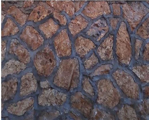
الشكل رقم: II. 34: يوضح نوع الحجارة المستعملة في أساس المدرسة (السور الخارجي) المصدر: من اعداد الطالبة
