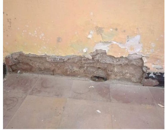
الشكل رقم : III. 22: يوضح تآكل البلاط والدرج
