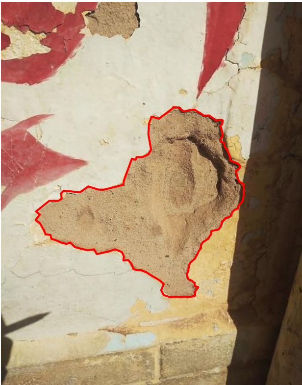
الشكل رقم: II. 42: يوضح ملاط الجير المستعمل في المدرسة
