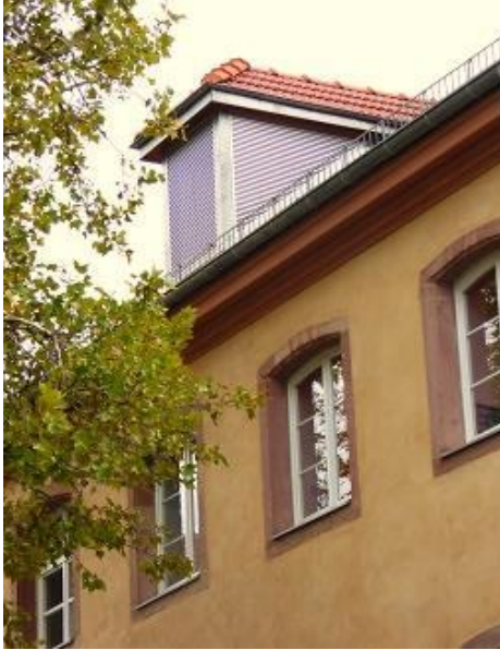
الشكل رقم: I. 27: وحدات التزويد بالهواء المصدر:
