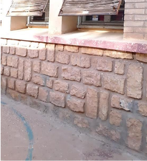
الشكل رقم: II. 33: يوضح نوع الحجارة المستعملة في أساس المدرسة (المبنى الداخلي) المصدر: من اعداد الطالبة
