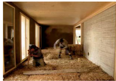
Figure 1.22: vue intérieur sur l'exemple 2, MAGAZINE DE CHANTIER
