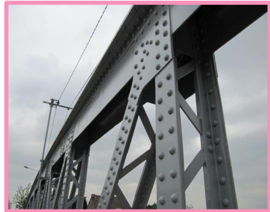
Fig V.27 : assemblage par rivets / source : : cours 3eme année : Mr boukhalkhal A
