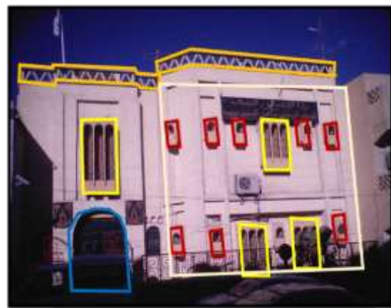
Figure 160 : Façade principale source : auteur
