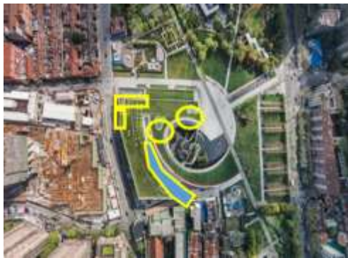
Figure 43 : toiture végétalisée Source : Auteur
