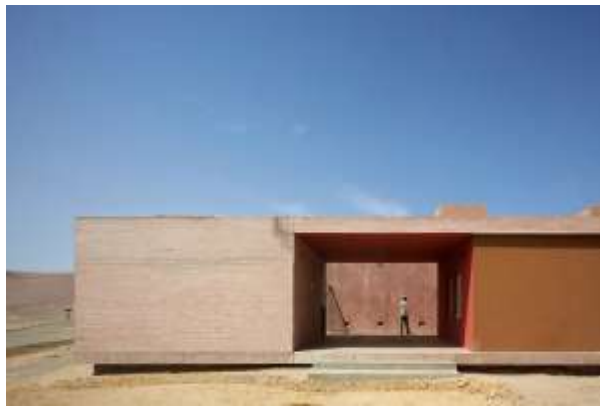
Figure 68 : Façade nord-est Source : https://www.archdaily.com/
