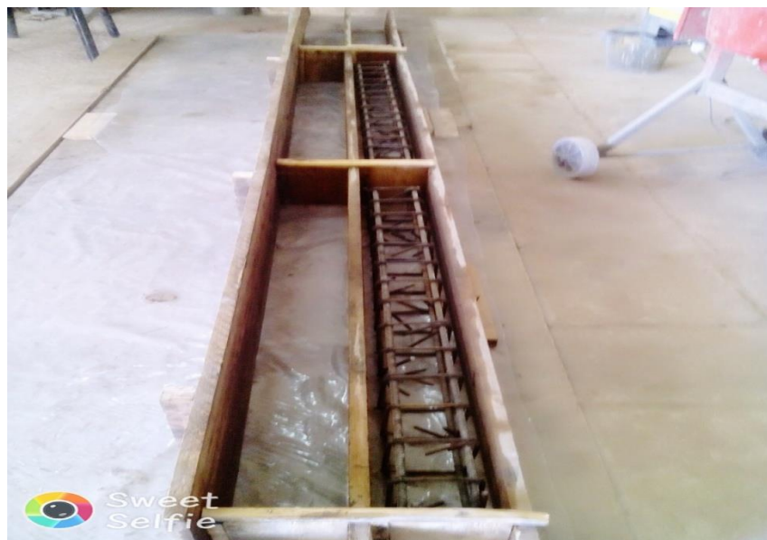
Figure II-6: Coffrage des poutres
