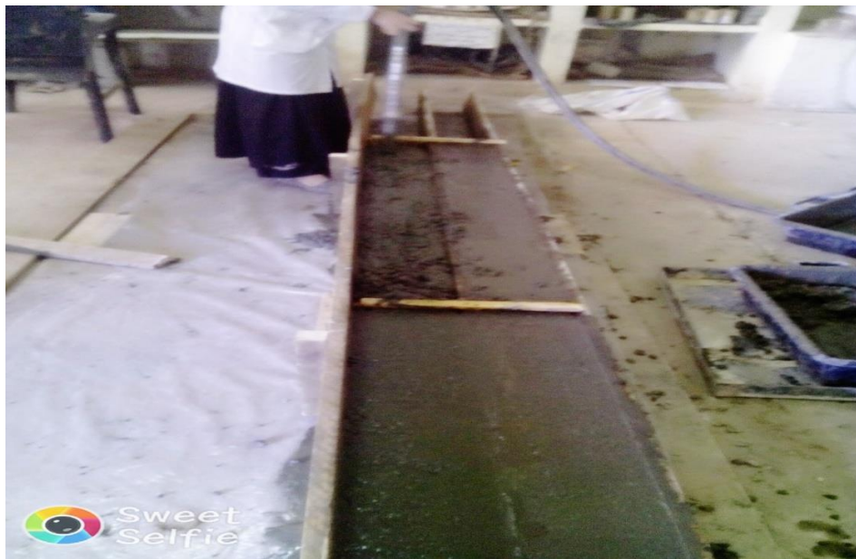
Figure II-11 : La vibration de béton.
