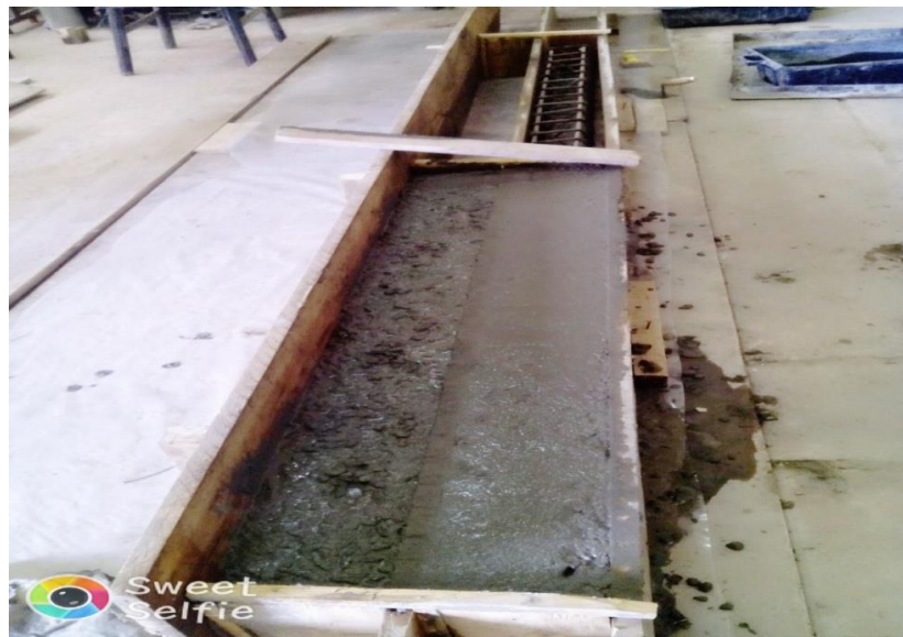
Figure II-10 : La mise en œuvre de béton dans les coffrages.
