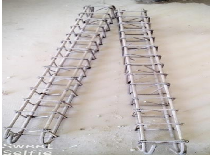
Figure II-8: Le ferrailage des poutres
