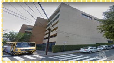
Figure I 48: Hôpital et école. [Source : https://earth.google.com .]
