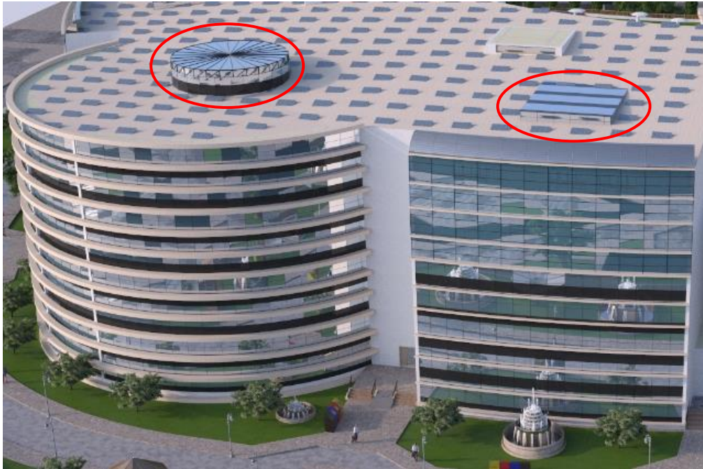
Figure V 12 : Confort visuel. [Source : auteur].
