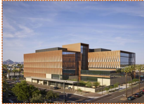
Figure I 67: Centre de cancérologie de l'Université d'Arizona. [Source : https://www.archdaily.com ].
