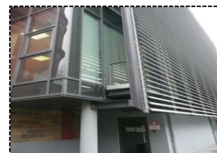
Figure I 36: Brise soleil. [Source : Rapport de présentation CAC AVRIL 2014].
