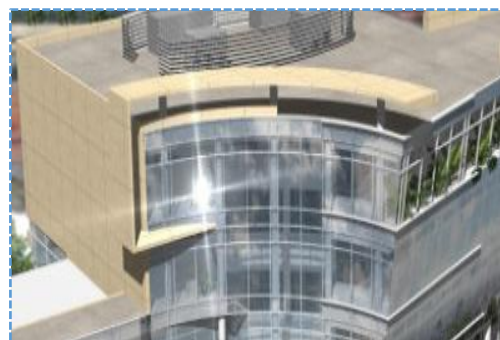
Figure I 60: brise solaire d'une forme de casquettes. [Source: http://www.worldarchitecturenews.com ].
