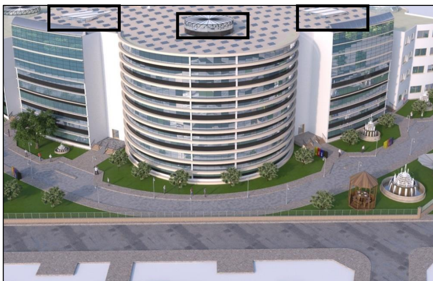
Figure IV 2: Façade sud. [Source: Auteurs].
