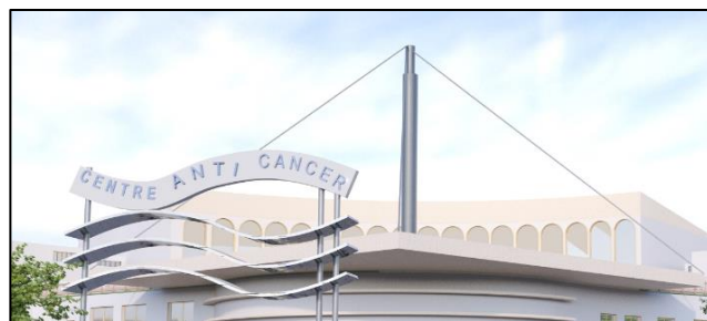
Fig. 10 : Toiture suspendu de l'entrée principale. [Source : Auteur].
