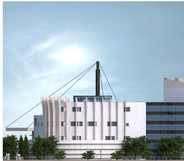
Figure IV 4: Façade ouest. [Source : Auteurs]
