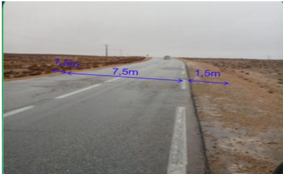
Figure I.2 : photo réelle du largeur de chaussée.
