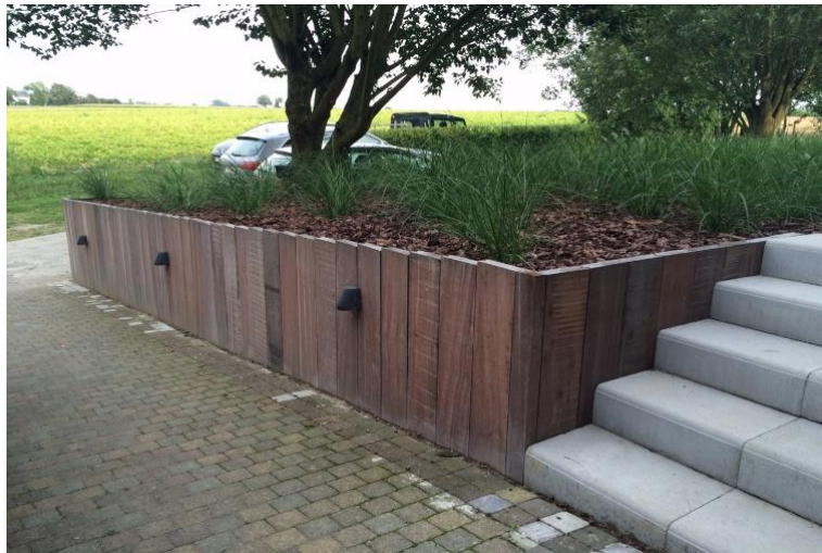
Figure.I.6 : Exemple palplanche en bois [8]
