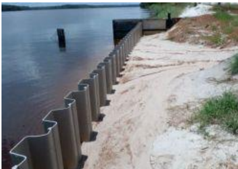
Figure.I.8 : Exemple palplanche en acier [10]
