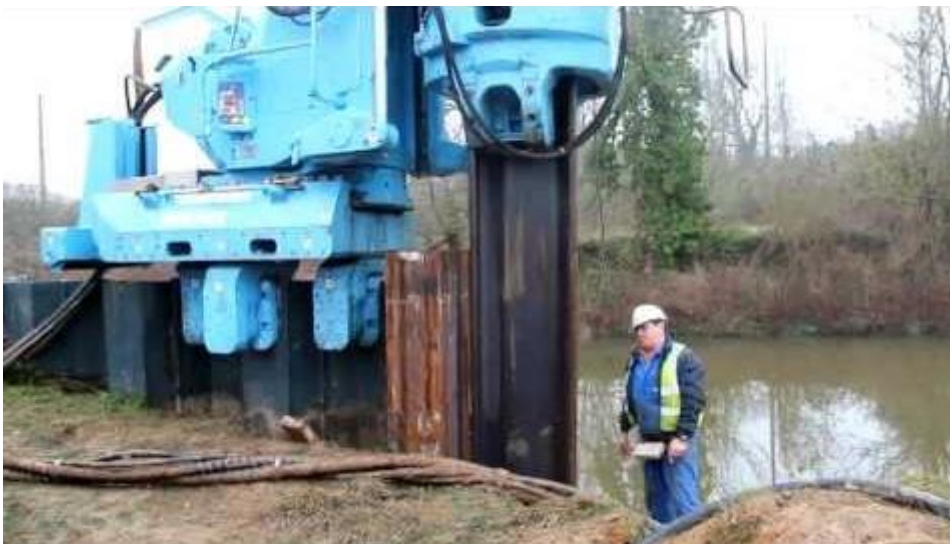
Figure.I.14 : Fonçage par serinage [16]
