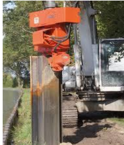
Figure.I.13 : fonçage par vibration [15]
