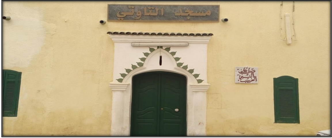
الصورة 33 : مسجد التاوتي
