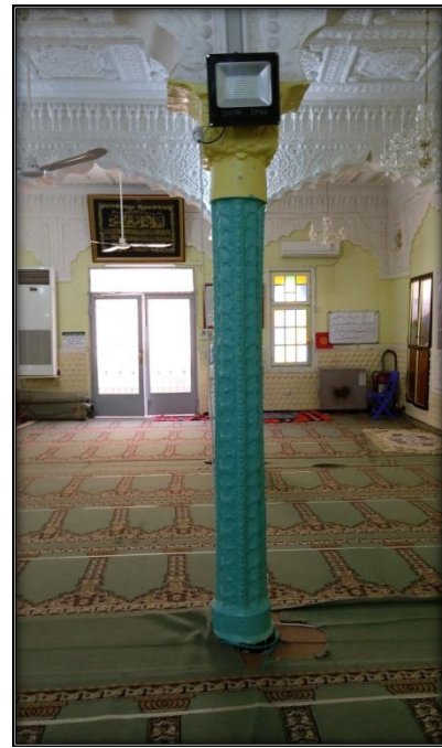
الصورة 27: احد اعمدة المسجد
