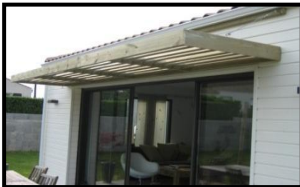
Figure 29 : brises solaires intégrés dans un habitat
