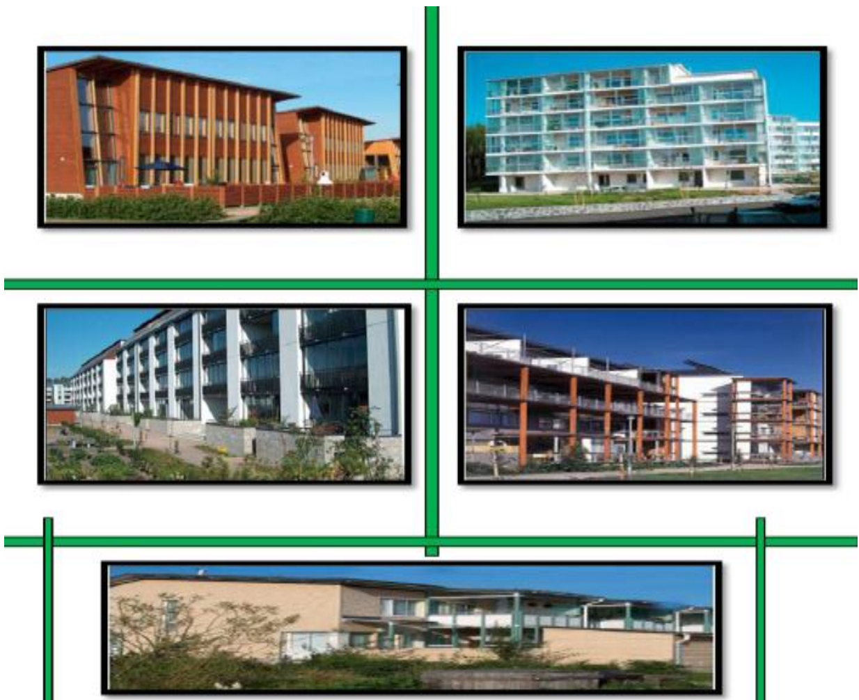
Figure 20 : l'ensemble des bâtiments qui compose le quartier
