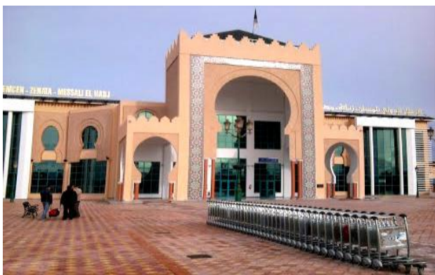
Fig.62: L'aéroport de Tlemcen « Messali El Hadj »
