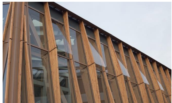
Figure 71: Palmes en bois de mélèze Source : ArchDaily
