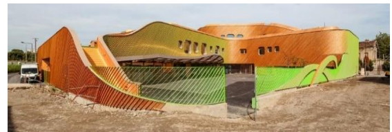
Figure 62 : Utilisation du bois
