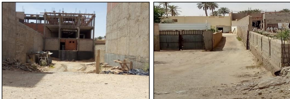
Figure IV 7. Vue sur l'expansion des constructions en béton au niveau de Khat El Oued (source : auteur).
