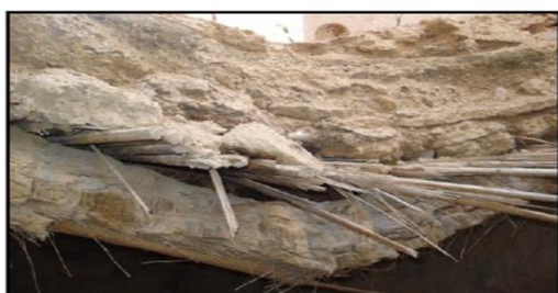
Figure I 7. Fléchissement et rupture de la poutre du plancher [9].
