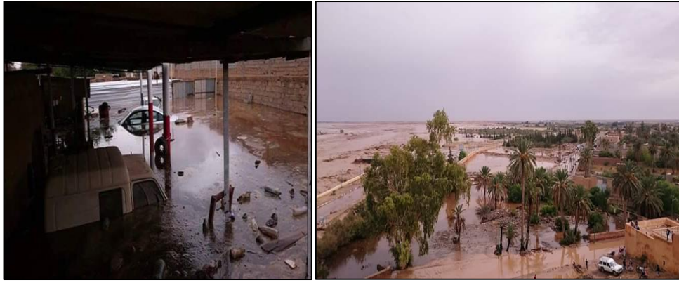
Figure IV 9. Vue globale sur la zone submergée (source : auteur).
