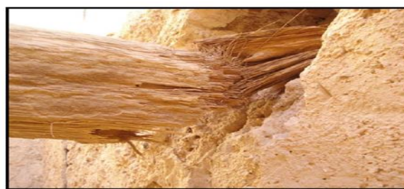
Figure I 7. Fléchissement et rupture de la poutre du plancher [9].
