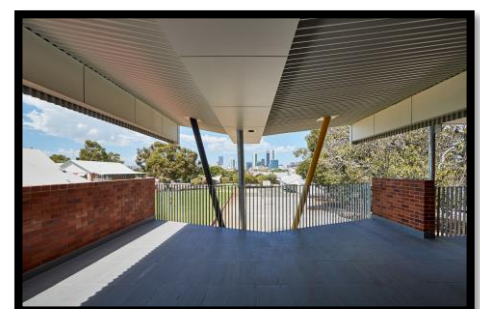
Figure 1.43 ; vue l'intirieur de l'école Source : www.archdaily.com
