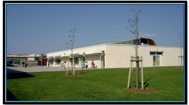
Figure 1.33 : Vue de l'école primaire au sud-est, la lucarne bioclimatique est visible sur le toit Source : thèse : ventilation et lumière naturelles
