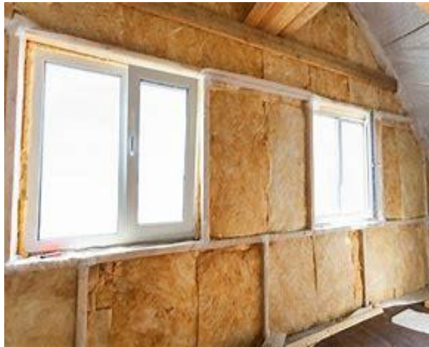
Figure 1-12. Isolation du mur par intérieur [33].
