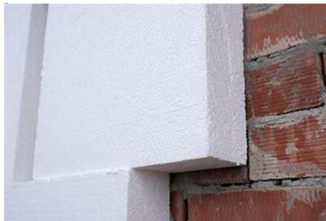
Figure 1-9. Isolation d'un mur avec le polystyrène [27].
