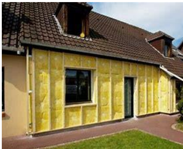
Figure 1-13. Isolation des murs extérieur [34].
