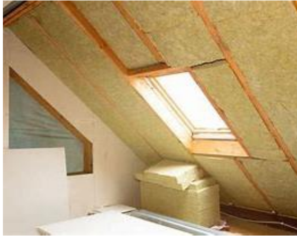
Figure 1-11. Isolation de toiture par intérieur [32].
