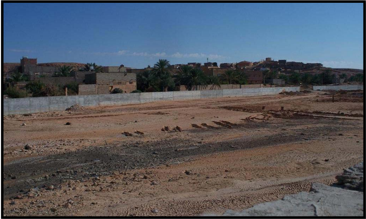
Figure 57. Exemple de l'achèvement du mur de soutènement d'Oued M'zab (Ghardaïa). ( source : auteur)
