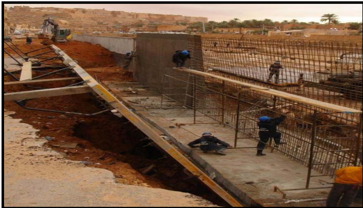
Figure 56. Exemple de réalisation d'un mur de soutènement des berges d'Oued M'zab (Ghardaïa). ( source : auteur)
