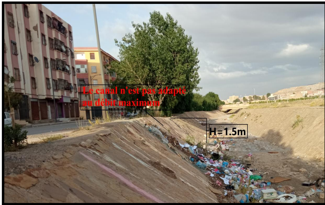
Figure 55. Présentation de la hauteur insuffisante des berges en pierre pour un débit maximal. ( source : auteur)
