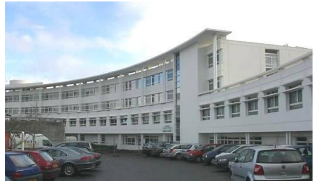
Figure 26:: la façade de l'aile hospitalisation de la polyclinique keraudren .source:: www.tetrarc.fr.
