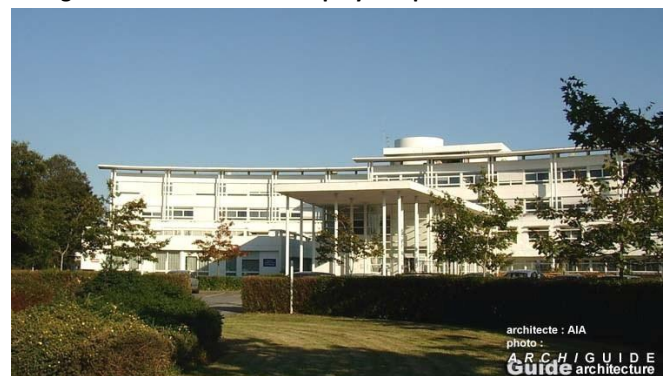
Figure 25::la façade principale de la polyclinique de keraudren. source: : www.tetrarc.fr.
