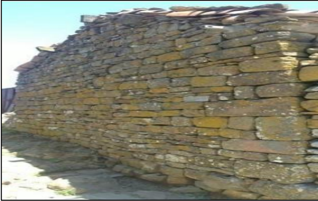
Fig. 47. Mur en pierre sèche source : Construction en pierre, OPVM
