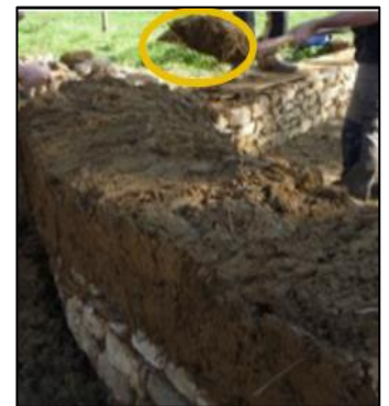
Fig. 51. Etape de compression, construction avec la bauge Source : Moulay Lakhdar .M . 2016
