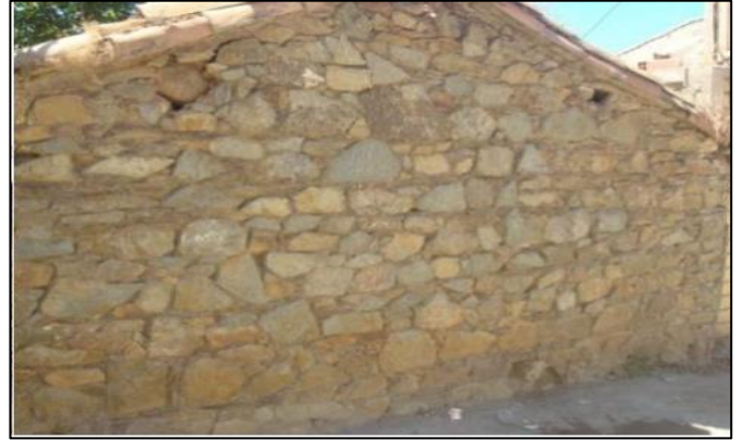
Fig. 46. Mur en pierre hourdées au mortier hétérogène Source : Construction en pierre, OPVM
