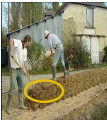
Fig. 53. Etape de préparation de construction avec la bauge Source : Moulay Lakhdar .M , 2016
