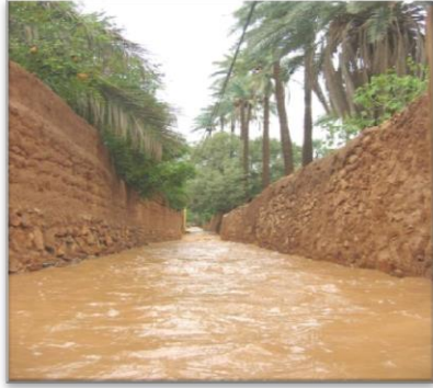
Fig. 28. Le chemin d'alimentation Source : 39 Khelifa.A, étude du système ancestral de captage et de distribution des eaux dans l'oasis de ghardaia,2008
