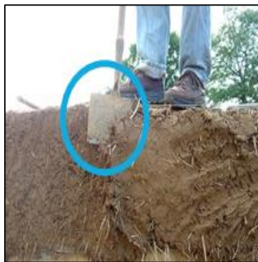
Fig. 52. Etape de moulage, construction avec la bauge Source : Moulay Lakhdar .M . 2016
