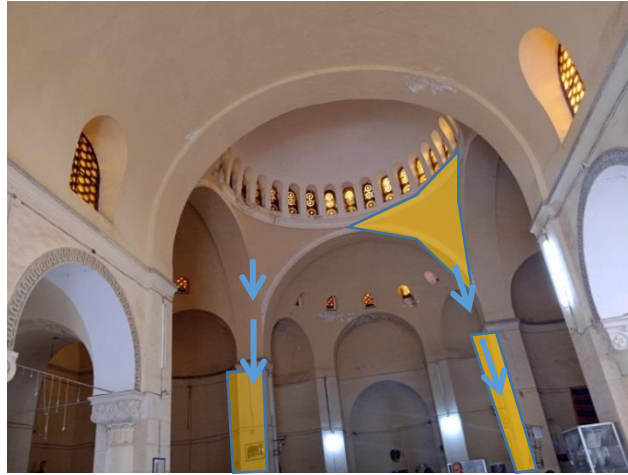
الشكل رقم: III - 43 : مرور القوى على الأعمدة المصدر : من رسم الطالبة / تصوير الطالبة 9. المواد البناء المستعملة في الكنيسة :
